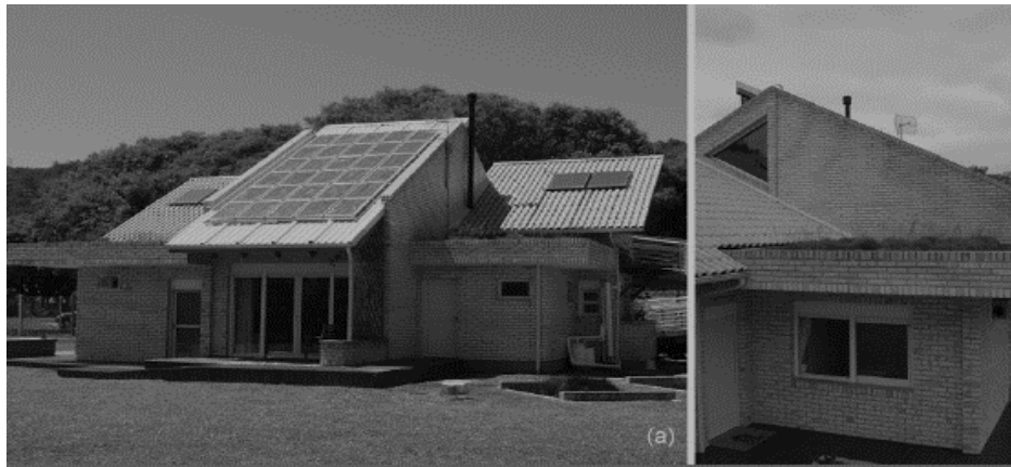
Figura 4. Fachada Norte y vista exterior del edificio experimental
