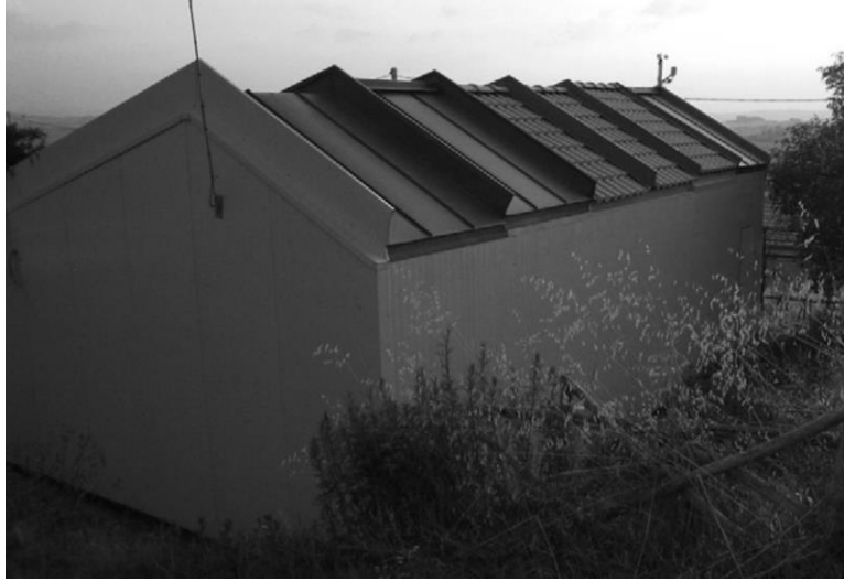
Figura 3. Vista exterior del edificio experimental cerca de Ancona (Italia): cuesta norte
