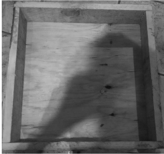
Figura 12. Cimbra para dar forma a concreto Fuente: Elaboración propia.
