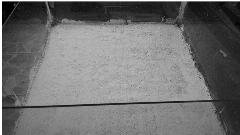
Figura 16. Aplicación de impermeabilizante.
