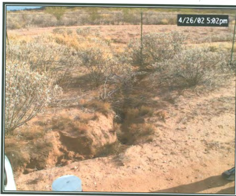
Figura 30. Cárcava localizada en la Zona 3. Fotografía de abril de 2002.
