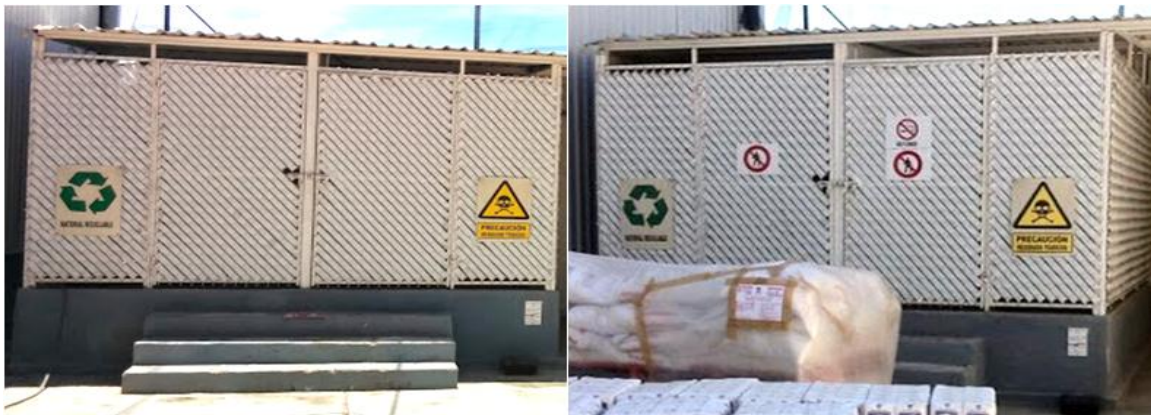
Figura 4.22. Señalización en cuarto de residuos peligrosos.
