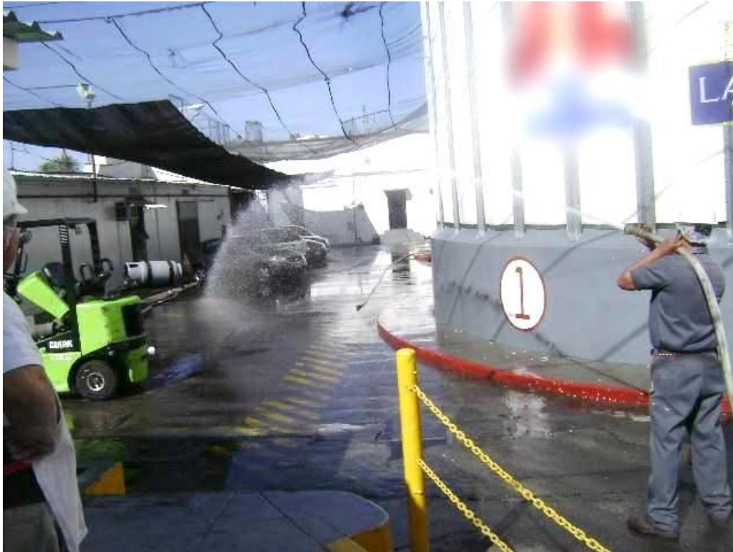
Figura 4.11. Pruebas al equipo contra incendios
