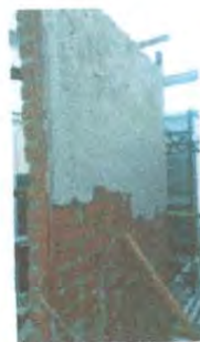
Figura 5.3: Levantamiento del muro de ladrillo perfectamente plomeado.
