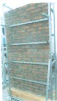
Figura 5.3: Levantamiento del muro de ladrillo perfectamente plomeado.
