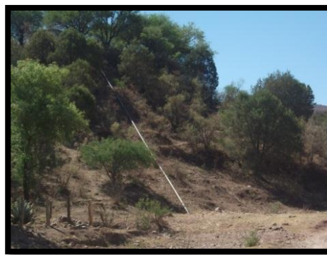
Imagen 2.19 Vista de la red de agua potable para el abastecimiento del ejido. Fuente: Autor
