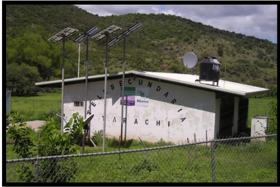
Imagen 2.20. Telesecundaria del ejido ubicada en la entrada. Fuente: Autor.
