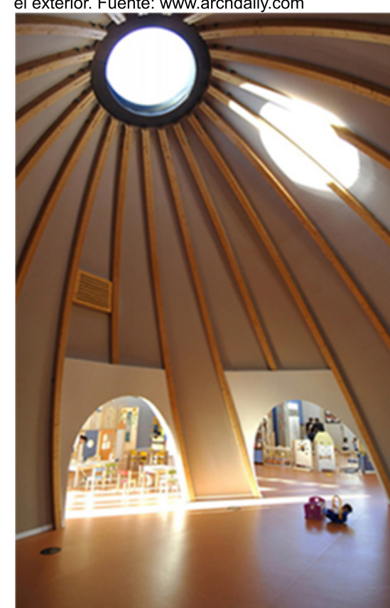
Imagen 1.7 Detalle de tragaluz. Fuente: www.archdaily.com
