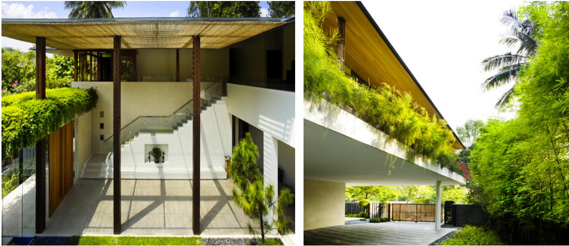
Imagen 28. Sombra. Protección solar con pergolado y climatización con vegetación, ejemplos. Fuente: Basado en Poler, M. Clima y Arquitectura
