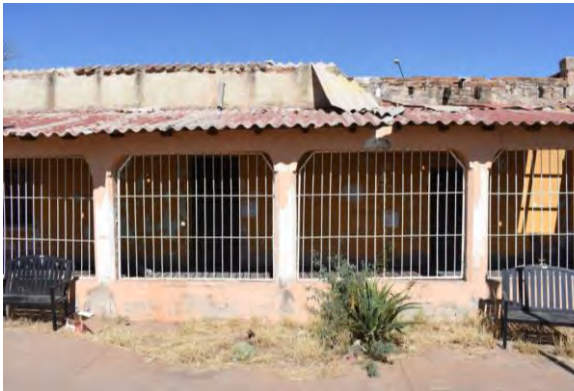
Imagen 32. Vivienda colindante con el Andador Histórico en la zona 1. Fuente. Archivo Propio.
