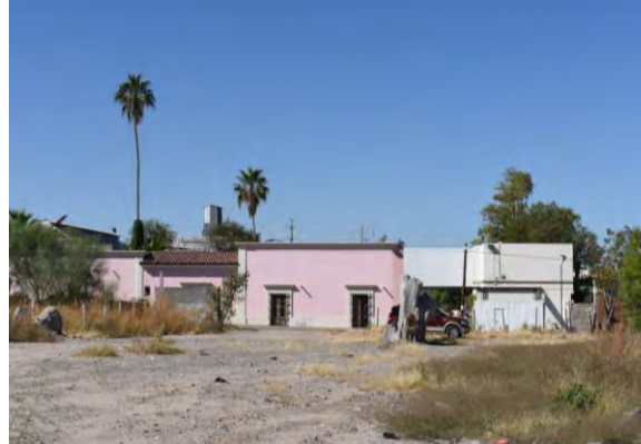
Imagen 31. Vista oeste desde zona 1. Fuente. Archivo Propio.
