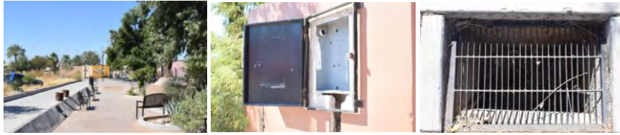
Imagen 39. Vista Zona 2 del Andador Histórico, Tablero Eléctrico y Alcantarillado en Villa de Seris. Fuente. Archivo Propio.
