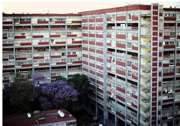
Fotografía 2. 8 Vista de otra de las fachadas del edificio. Fuente: www.obrasweb.mx
