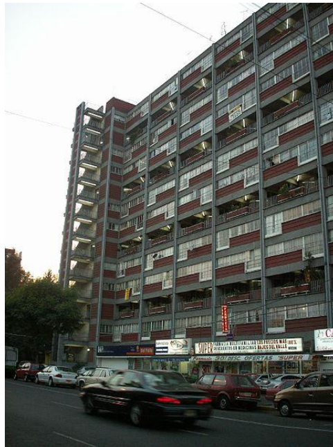
Fotografía 2. 7 Fachada en donde se aprecia la forma del multifamiliar. Fuente: www.wikipedia.com .
