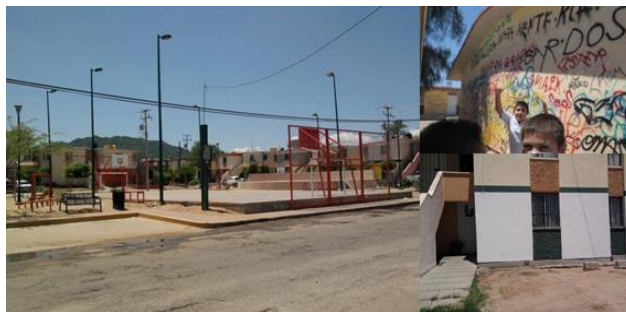
Fotografía 1. 5 Vivienda con evidente deterioro de la colonia Nuevo Hermosillo Fuente: www.hermosillo.olx.com.mx
