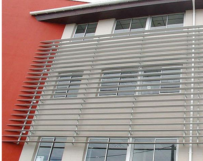
Imagen 32: Louvers en ventanas.
