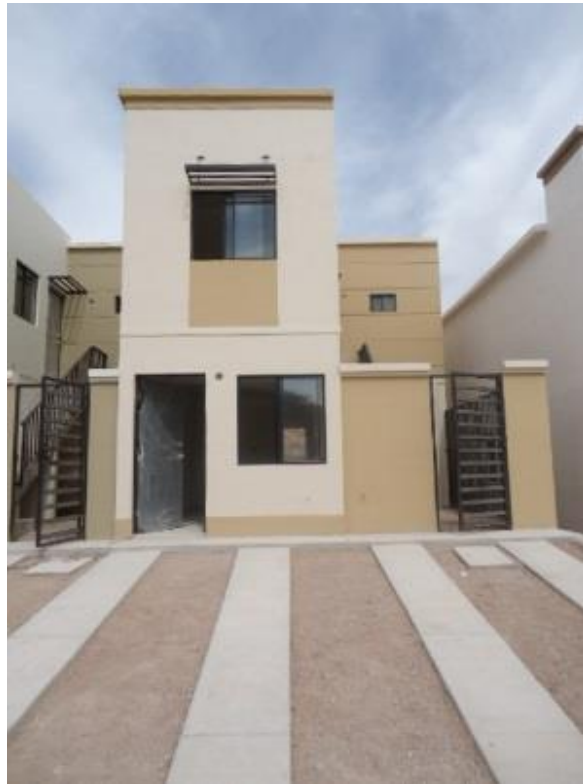
Imagen 46 Fotografía tomada en el exterior, en donde se aprecia la fachada del modelo verona. fuente: archivo personal.
