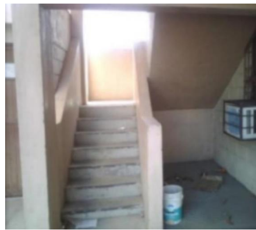
Imagen 65 módulo de escaleras del conjunto piña, fuente: Quintana Rolon, José Manuel
