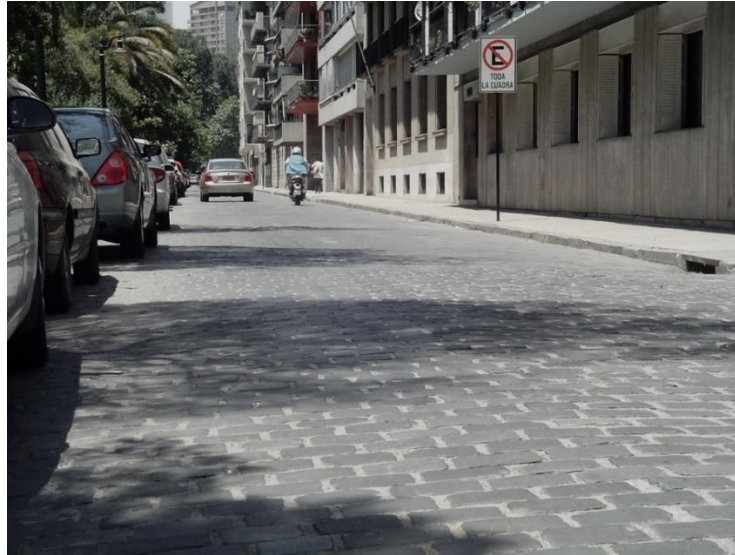
Imagen 109 Calzada con tabile de concreto con juntas de cemento en Ciudad de México, fuente: FUENTE: www.duiops.net
