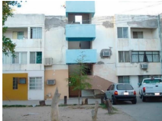
Imagen 50 fachada lateral del conjunto Fovissste, fuente: archivo personal
