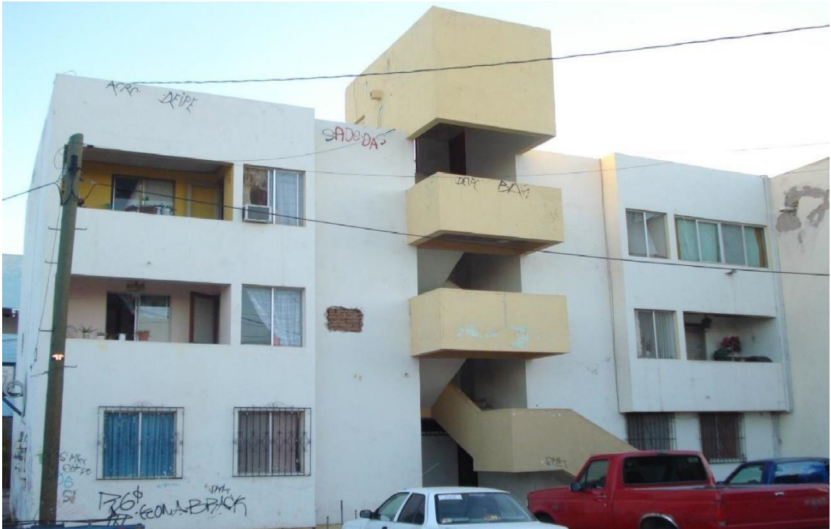
Imagen 47 Fachada Conjunto Fovissste, Fuente: Archivo personal
