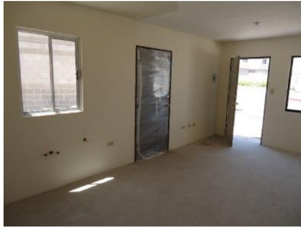
Imagen 42 Fotografía tomada en el interior de la planta baja de una vivienda del modelo verona, se puede apreciar que se cuenta con una buena iluminación y la altura es adecuada., Fuente: Archivo personal
