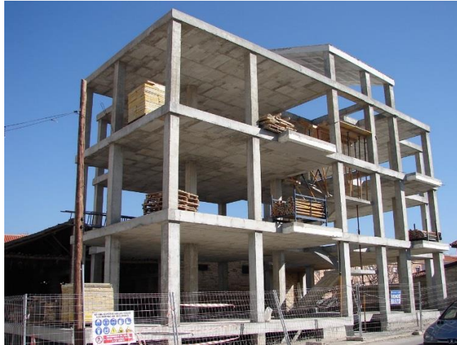
Imagen 101 Esqueleto de concreto edificio Ciudad de México, fuente: http://1.bp.blogspot.com/_-rYfxCeAmsw/TB3cxEiN8cl/AAAAAAAAACM/I6GfxOjencs/s1600/DSC02914.jpg
