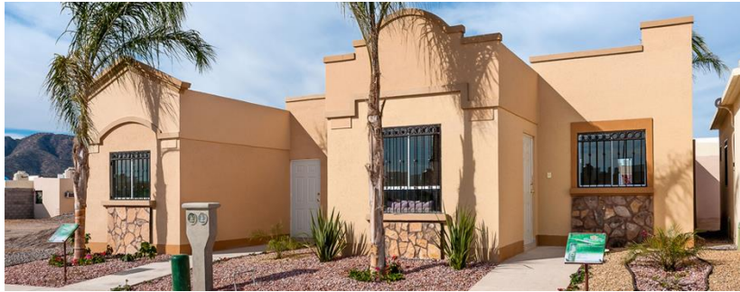
Imagen 17 Vivienda interés social ubicada en Hermosillo sonora. prototipo de la colonia puerta del rey de milenium, fuente: http://puertadelrey.mx/wp-content/uploads/2013/10/2.jpg
