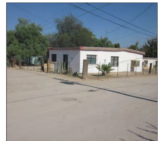
Foto 2 : Vista del Punto 2. Esquina calle San Pedro con José López Portillo.
