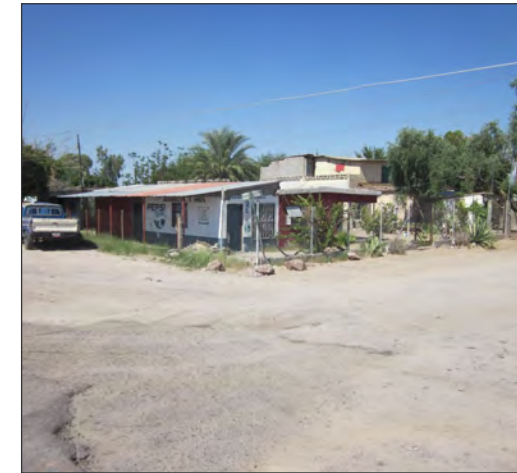
Foto 1: Vista del Punto 1. Esquina calle Del Maestro con Carretera a B. Hill.
