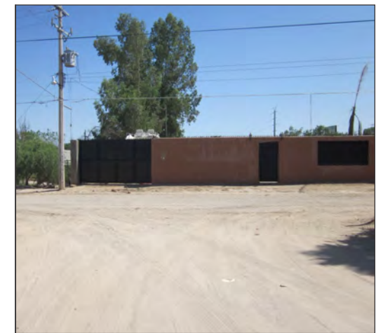
Foto 2 : Vista del Punto 2. Intersección de la calle Del Maestro con S/N 10.
