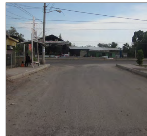
foto 5: Vista Norte - Sur, sobre la Calle Roberto Ramírez. (tramo B)
