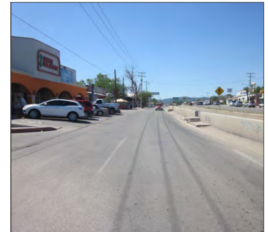
Foto 4 : Vista Este - Oeste, sobre la Carretera Federal 14. (tramo A)
