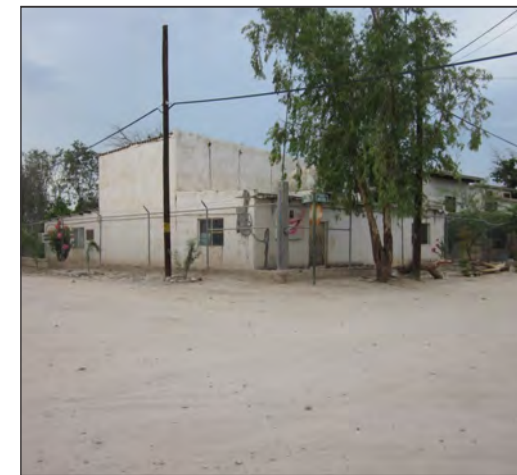
Foto 1: Vista del Punto 1. Esquina calle Del Maestro con Hidalgo.
