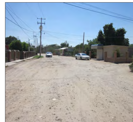
foto 5: Vista Norte - Sur, sobre la Calle Rómulo Córdova. (tramo B)
