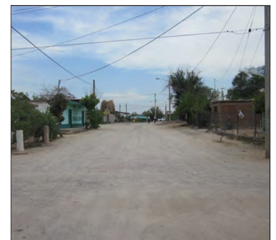
Foto 6: Vista Sur - Norte, sobre la calle Hidalgo. (tramo B)
