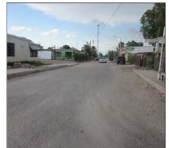
Foto 6: Vista Sur - Norte, sobre la calle Roberto Ramírez. (tramo B)
