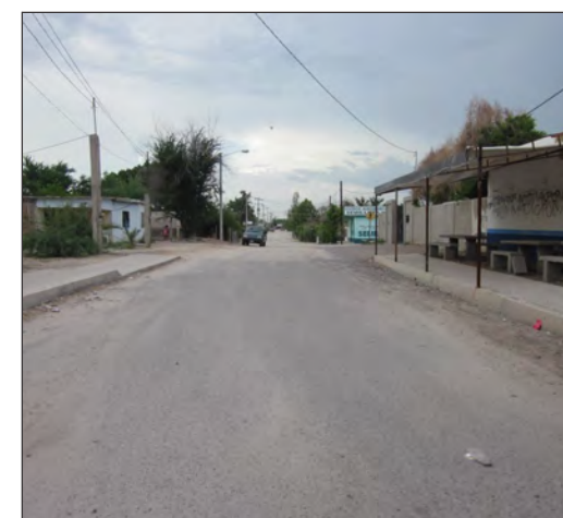
foto 5: Vista Sur - Norte, sobre la Calle Hidalgo. (tramo B)
