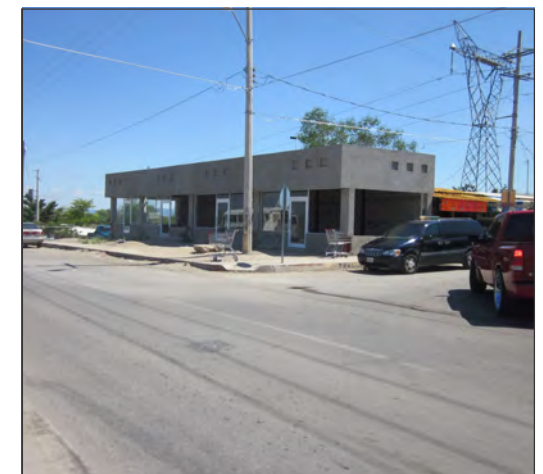
Foto 2 : Vista del Punto 2. Esquina calle Rómulo Córdova con Carretera Federal 14.
