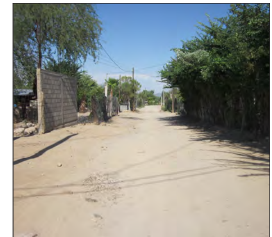
Foto 4 : Vista Oeste - Este, sobre la calle Apaches. (tramo A)
