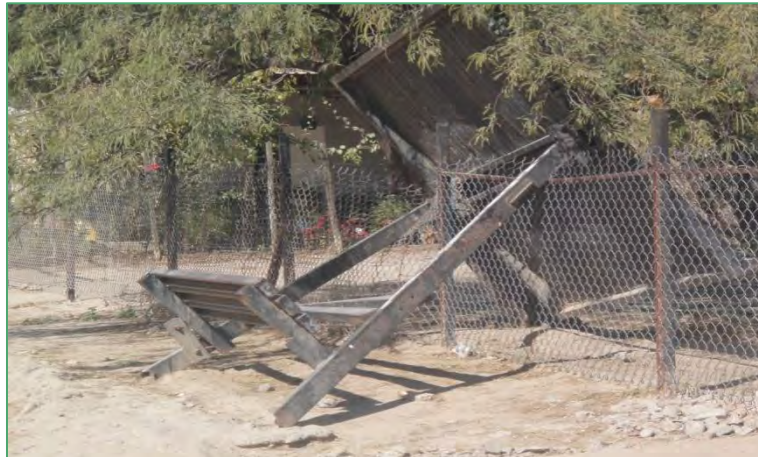
Imagen 33: para de autobús sobre la calle del Maestro, en muy mal estado.
