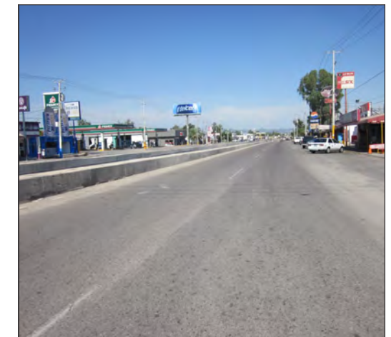
Foto 4 : Vista Oeste - Este, sobre la Carretera Federal 14. (tramo A)
