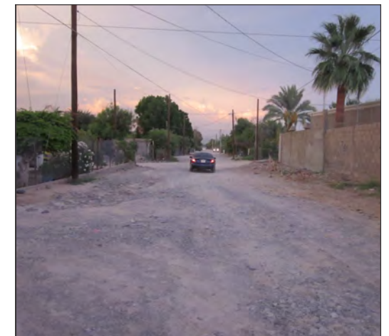
Foto 4 : Vista Oeste - Este, sobre la calle Zacatecas. (tramo A)
