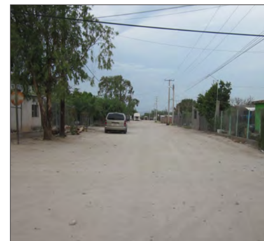
foto 5: Vista Oeste - Este, sobre la calle Del Maestro. (tramo A)
