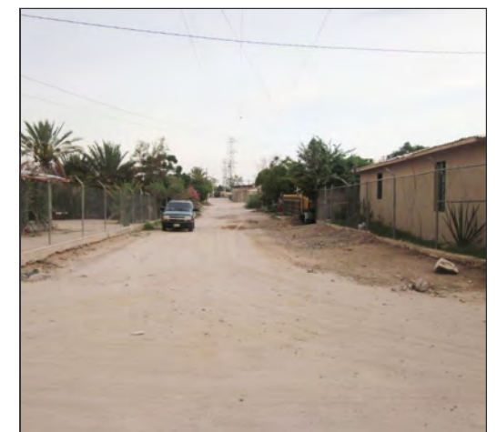
Foto 6: Vista Sur - Norte, sobre la calle San Pedro. (tramo B)
