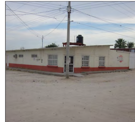
Foto 3 : Vista del Punto 3. Esquina calle Del Maestro con Hidalgo.
