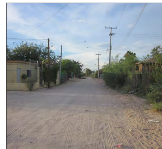
foto 5: Vista Sur - Norte, sobre la calle Revolución. (tramo B)
