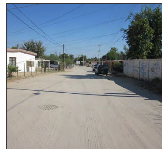
foto 5: Vista Norte - Sur, sobre la Calle San Pedro. (tramo B)
