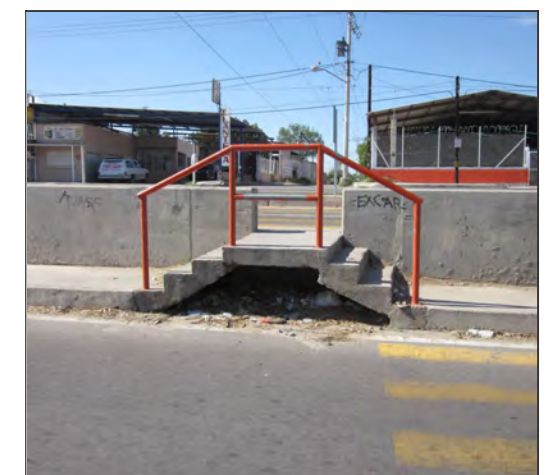
Foto 6: Detalle de escaleras en cruce peatonal en Carretera Federal 14.
