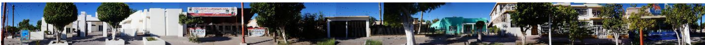
Ilustración 47: Larguillo 5. Calle Héroe de Nacozari. Carácter habitacional con transiciones al giro comercial. Se encontraron desniveles en banqueta y descuido en cajetes. (Fuente: Archivo personal).
