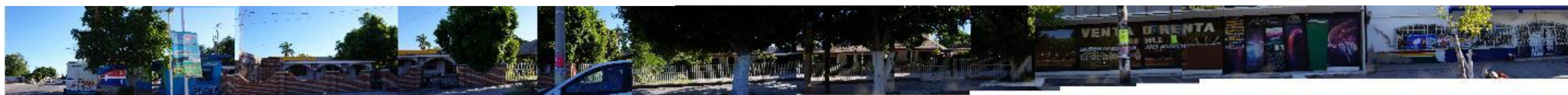
Ilustración 57: Larguillo 19. Avenida Reforma. Carácter comercial de origen habitacional. Banquetas deterioradas. (Fuente: Archivo personal).
