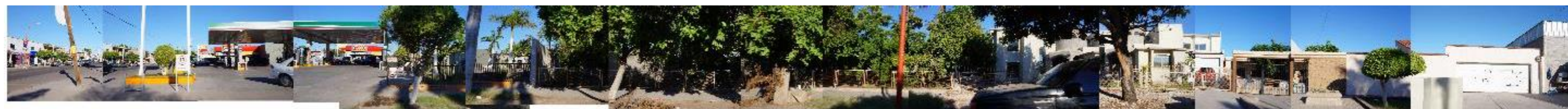
Ilustración 64: Larguillo 34. Calle Benito Juárez. Carácter comercial y habitacional. Deterioro en banquetas, falta de sombra, rampas y mobiliario. (Fuente: Archivo personal).
