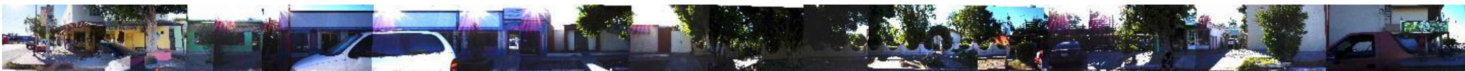
Ilustración 51: Larguillo 6. Calle Nicolás Bravo. Carácter mayormente comercial con origen habitacional. Banquetas dañadas. (Fuente: Archivo personal).
