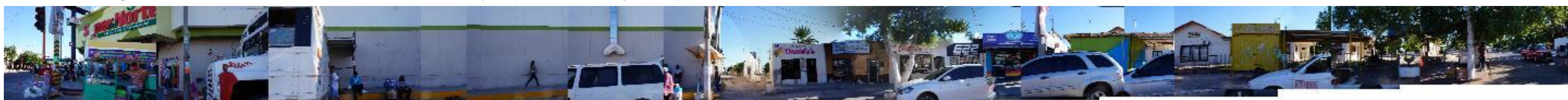
Ilustración 55: Larguillo 21. Avenida Reforma. Carácter comercial. Rampas inexistentes o con pendiente pronunciada. Acceso a banqueta por escalones. (Fuente: Archivo personal).
