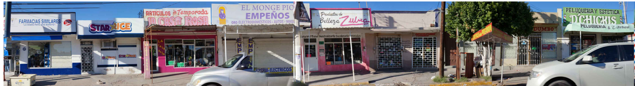
FOTOGRAFÍA DE FACHADAS ESTADO ACTUAL S/E
