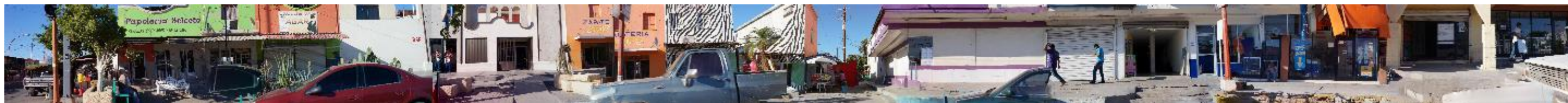
Ilustración 61: Larguillo 15. Avenida Reforma. Carácter comercial. Hasta 3 niveles diferentes en banquetas. (Fuente: Archivo personal).
