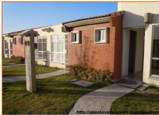
Imagen 2.5- Casa de interés social de Toluca, Estado de México, una vista exterior. Fuente: almolovade juarez.campusanuncios.com .mx
