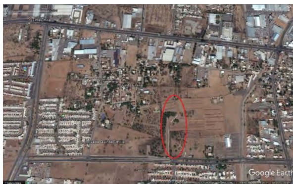
Ilustración 4: Para mayo del 2016, se dejó a medias el canal (en rojo) debido a disputas legales con vecinos Fuente: Google Earth, Digital Image. Modificado
