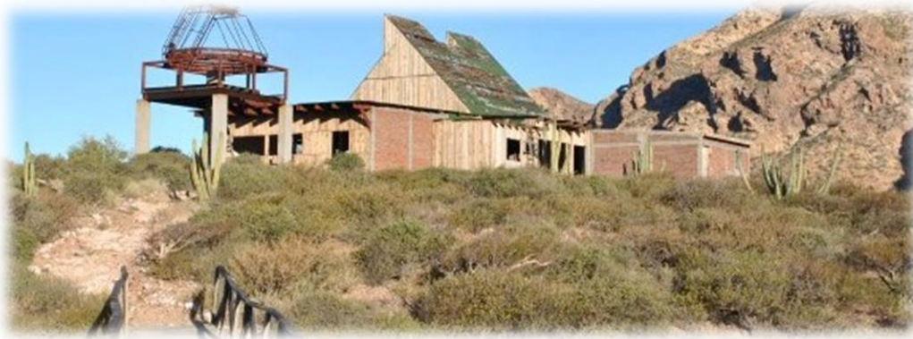
Imagen 1. Vista posterior puente, torre de observación y casa club. (Fuente http://www.panoramio.com/ )
