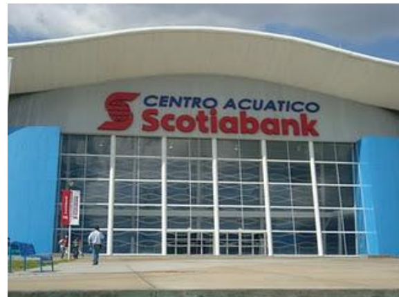
Ilustración 17 Vista Exterior e interior del Centro Acuático ScotiaBank. Fuente Vive Guadalajara.
