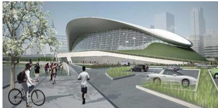
Ilustración 15 Muro Verde, Complejo Acuático de Londres. Fuente Treehugger.
