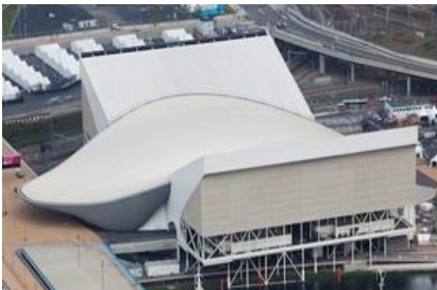
Ilustración 8 Centro acuático de Londres, con la gradería que se desmontó después de los J.O. Fuente Architen.
