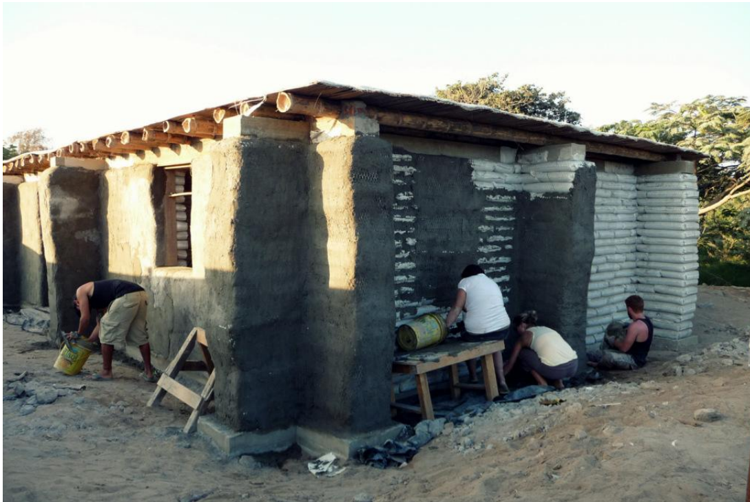
Fig.3.71.- Voluntarios colocando el recubrimiento sobre muros exteriores. (Foto: Voluntario de PSF)
