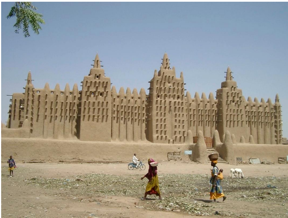
Fig.3.22.-Vista exterior de la gran mezquita de Djenné en Mali.
