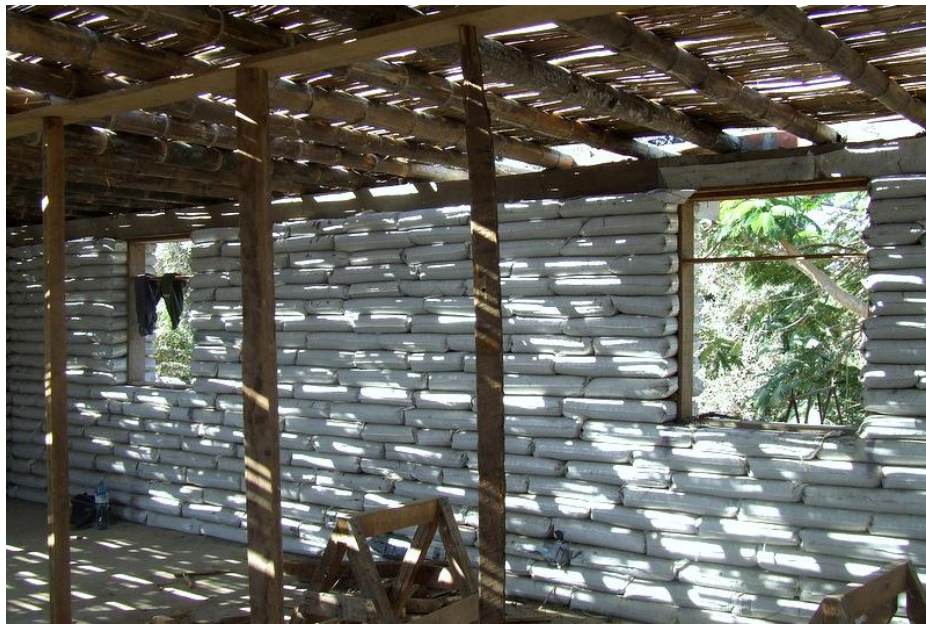
Fig.3.48.- Edificación rectangular con cubierta de bambú usual en la zona como estructura para la elaboración de techos. (Foto: Autor*)
