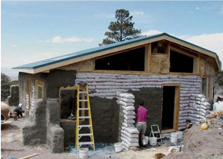
Fig.3.49.- Este ejemplo muestra la mezcla de 3 diferentes elementos: Sacos, pacas y madera. (Foto: SDA*)
