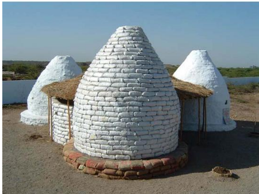
Fig.3.47.- Se muestran edificaciones de un solo elemento (muro-cubierta) posible gracias a su forma circular. (Foto: SDA*)
