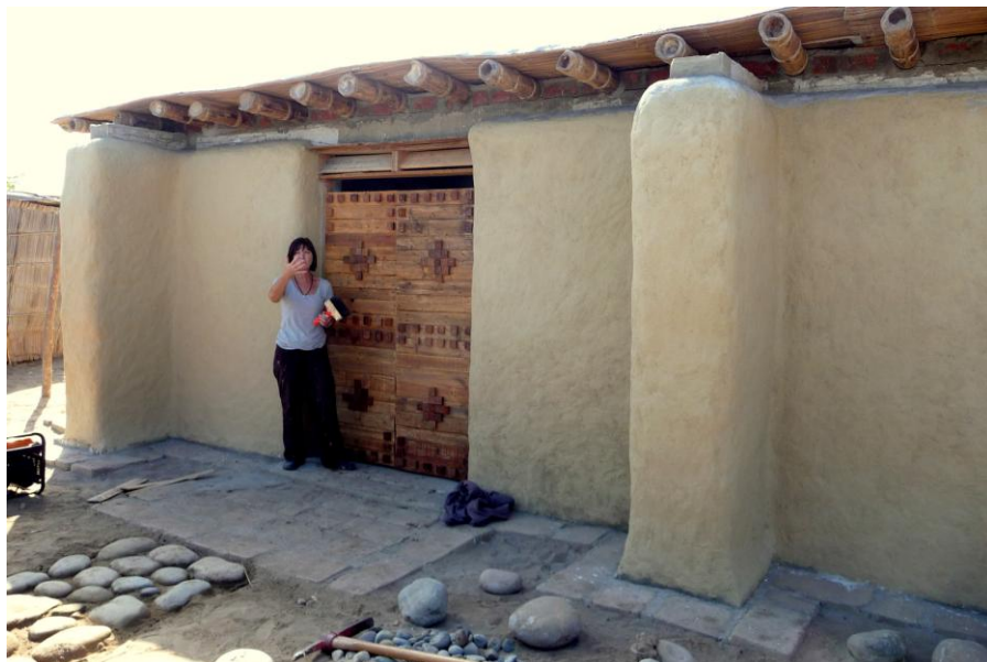
Fig.3.62.-. Muro pintado con pintura a base de pigmentos naturales, tras una primera capa de sellador que nos permite a que el mortero no absorba la pintura.
