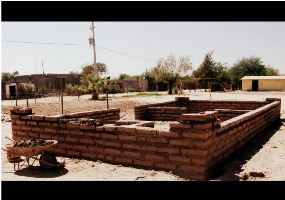
Fig.2.13.- Vivienda de adobe en elaboración por integrantes de la comunidad. Foto: Nahuel Moreno.
