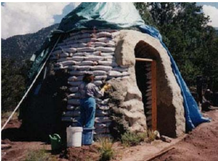
Fig.3.61.-. Revestimiento de muros exteriores e interiores con mortero de Papel: Cemento: Arena.
