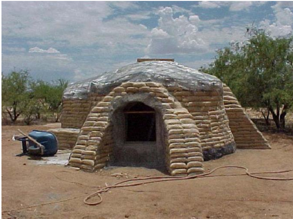
Fig.3.51.- Colocación de hule para brindar mayor impermeabilidad a la vivienda ya que los sacos utilizados no es de polipropileno sino de tela. (Foto: SDA*)
