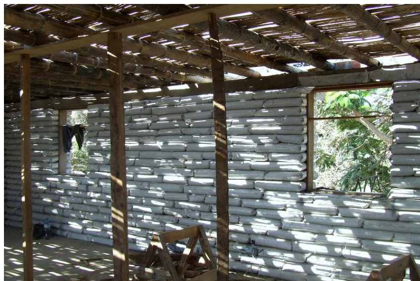
Fig.3.67.- (Arriba) Vista de estructura de acero de refuerzo colocada sobre el cerramiento del muro. (Foto: Autor*)
