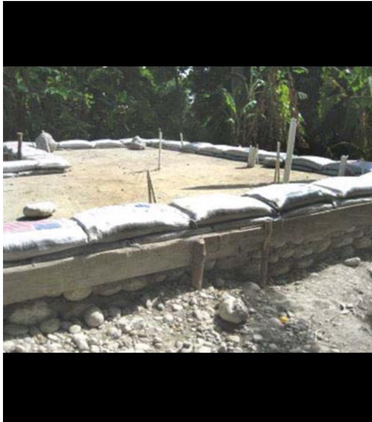
Fig.3.40.- Cimentación elaborada con mampostería (SDA*)
