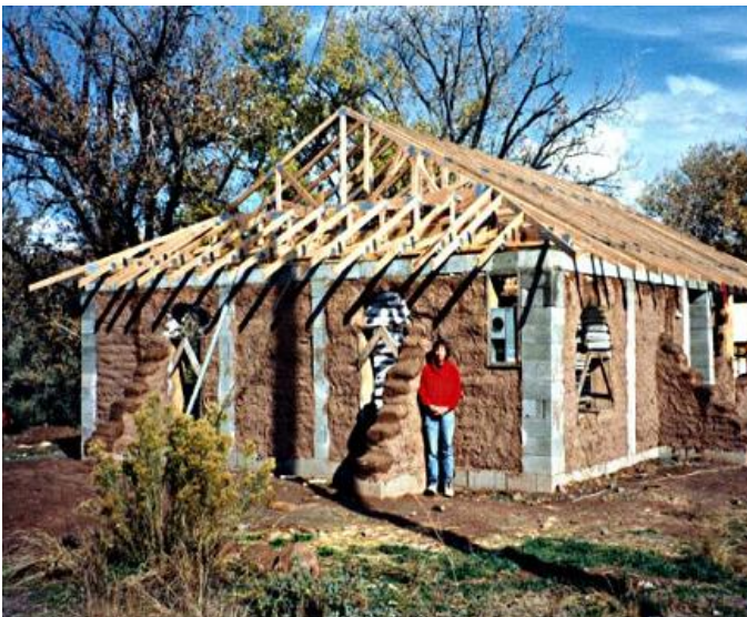
Fig.3.59.-. En el caso de que la estructura sea a base de pilares de hormigón o de madera, la cubierta puede tener cualquier tipología tradicional. En este caso vemos
