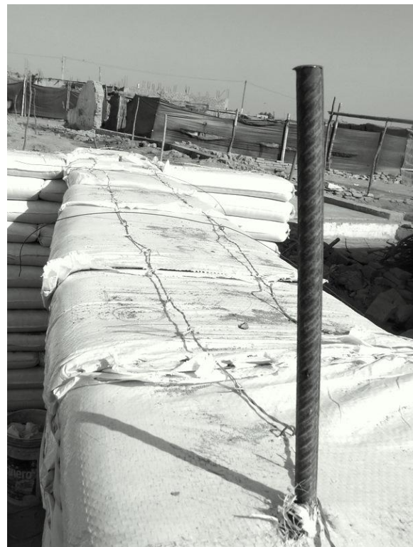
Fig.3.46.- Se muestra una varilla anclada sobre varias hiladas de bolsas además de alambre de púas lo que dará a esta edificación una gran resistencia ante los sismos. (Foto: Autor*)
