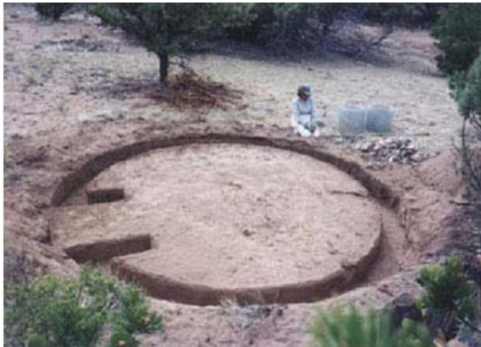
Fig. 3.38.- Excavación lista para recibir cimentación de grava y malla metálica. (Sin datos de autor SDA*)
