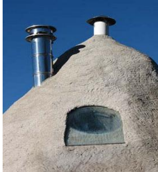
Fig.3.56.-.Instalación de chimenea y ventilación el parte superior a las carpinterías de la vivienda. (CDA*)
