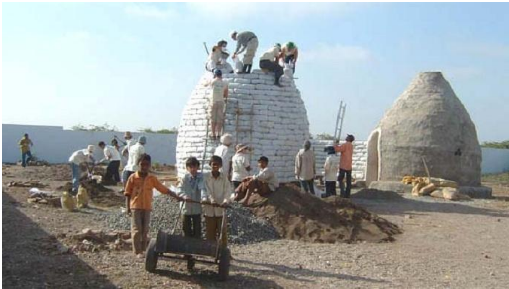
Fig.3.42.- Niños colaborando en la edificación de un grupo de viviendas en Irán. (Foto: SDA*)
