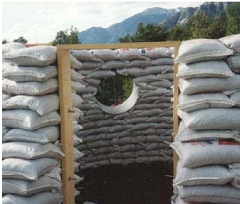
Fig.3.52.- Se puede observar en el ejemplo 2 soluciones de apertura de vanos, una mediante el uso de carpintería y otra mediante el uso de un encofrado circular a base de tubería galvanizada. (Foto: SDA*)
