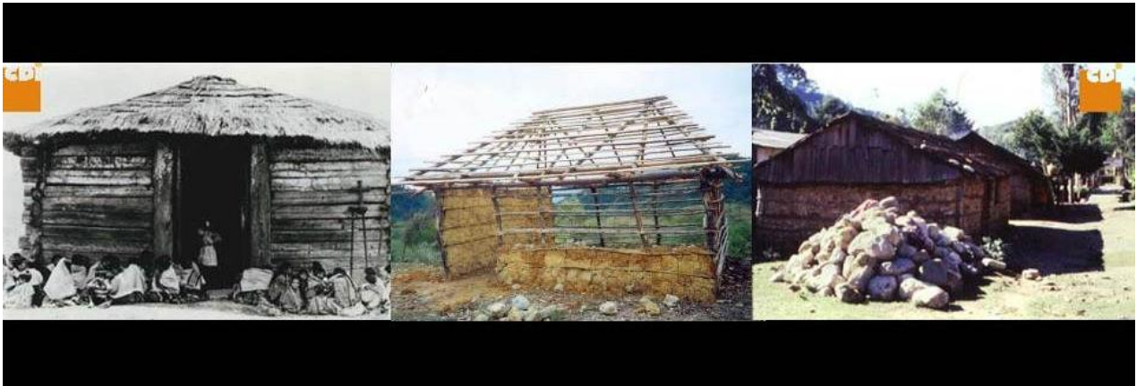
Fig.1.3.- Tipología de vivienda Triqui. Dos soluciones constructivas distintas, una misma forma.
