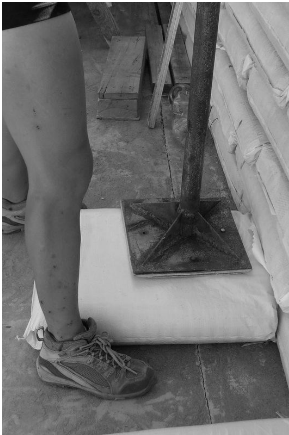
Fig.3.44.- Compactación de saco relleno antes de su colocación en muro, mediante herramienta elaborada con acero y madera.
