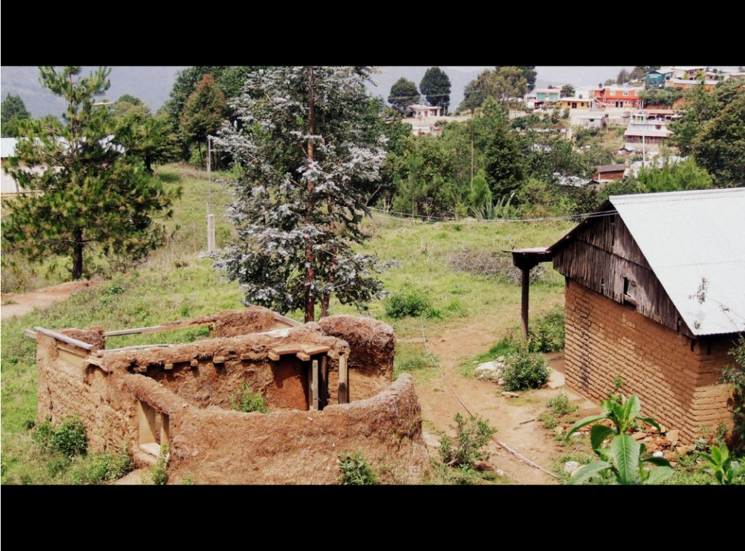
Fig.1.2.- Vivienda Triquis. A la izquierda se observa el sistema constructivo basado en troncos y paja u otras ramas entreteljidas mezcladas con tierra y a la derecha se puede observar una vivienda en mejores condiciones utilizando el sistema de adobe tradicional. Foto: Isaías Rivas*
