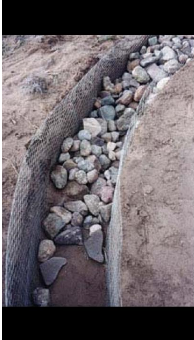
Fig.3.39.- Excavación y preparación para cimiento en proyecto de bolsas de tierra.
