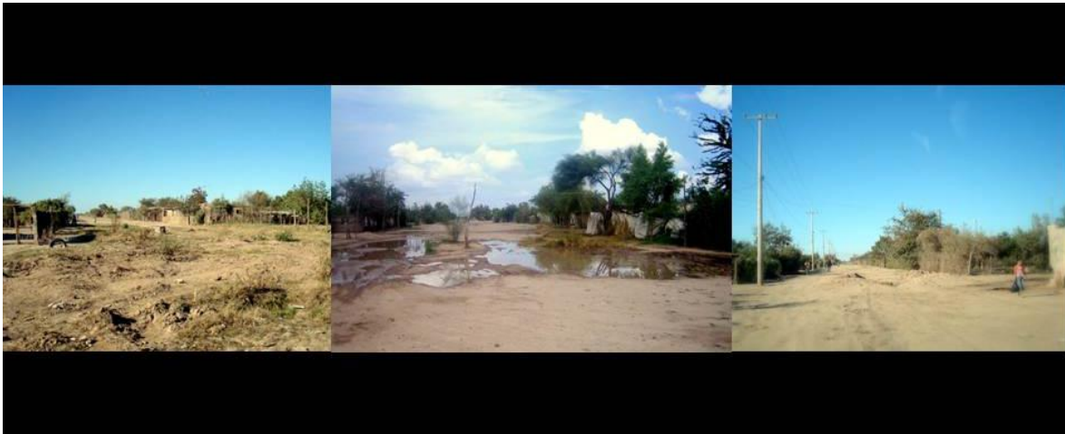
Fig.2.9.- Obsérvense 3 ejemplos de calles con diferentes ejemplos del deplorable estado en el que se encuentran éstas. (Fotos: Autor*)
