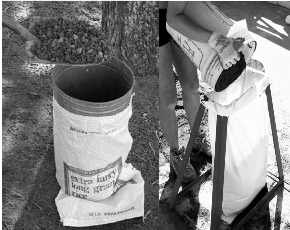
Fig.3.43.- Elementos modificados o fabricados para facilitar el vertido del relleno dentro de los sacos de arena. (Foto: Autor*)
