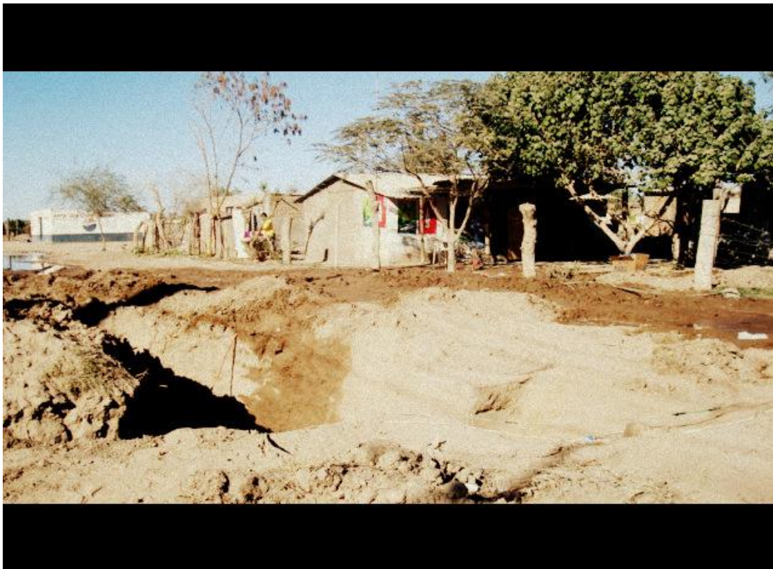
Fig.2.7.- Excavaciones para instalación de red hidráulica. (Foto: Autor*)
