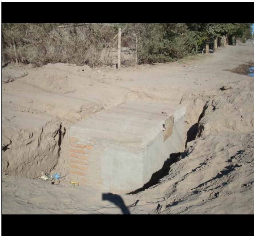
Fig.2.8.- Se observa obra de alcantarillado en elaboración. (Foto: Autor*)
