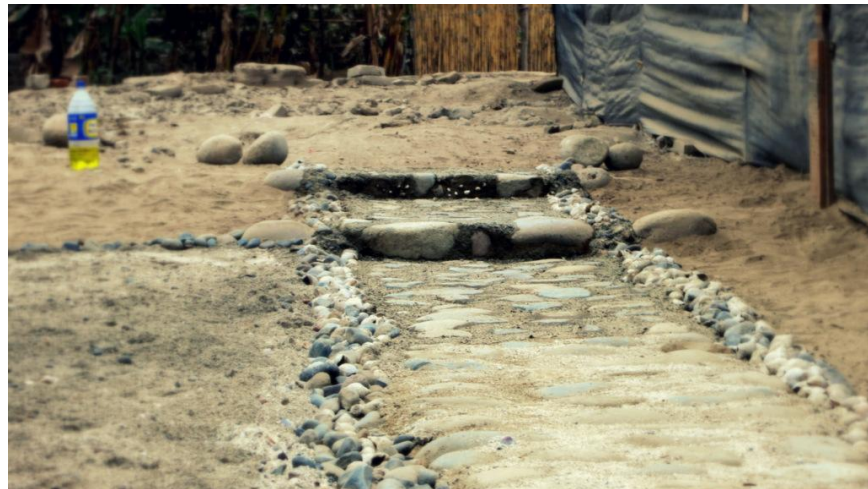
Fig.3.76.- Detalle del “Inca track” a excepción del concreto, todo el camino está elaborado con materiales del medio circundante. (Foto: Autor*)
