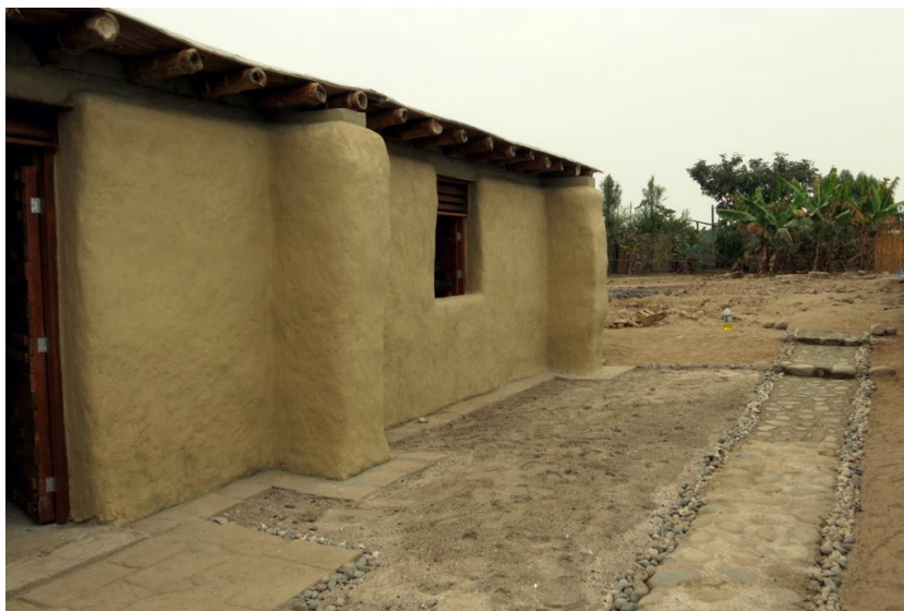
Fig.3.77.- Vista del proyecto finalizado. Se puede notar el rodapié y el tapete elaborados con adobe reciclado así como el demás trabajo de paisaje.
