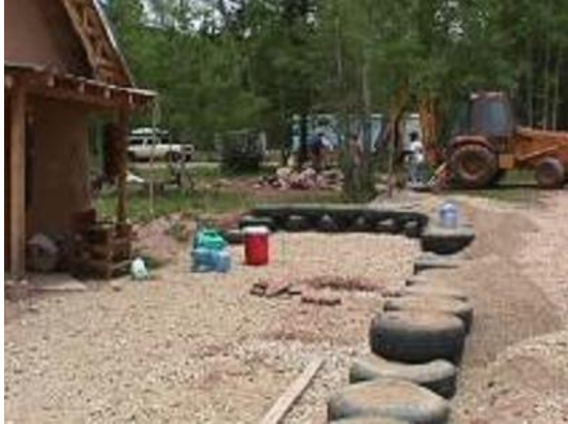
Fig.3.41.- Cimentación elaborada con neumáticos sin necesidad de generar excavación para esta. (Foto: SDA*)
