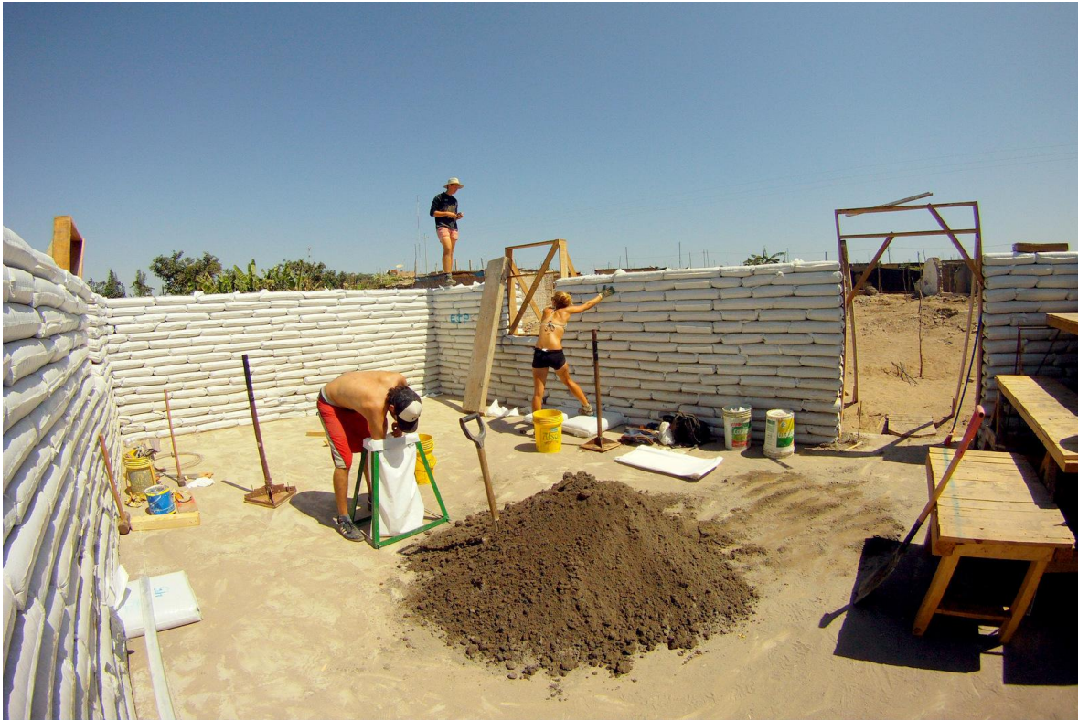
Fig.3.67.- Vista de voluntarios trabajando en la edificación de los muros. (Foto: Autor*)
