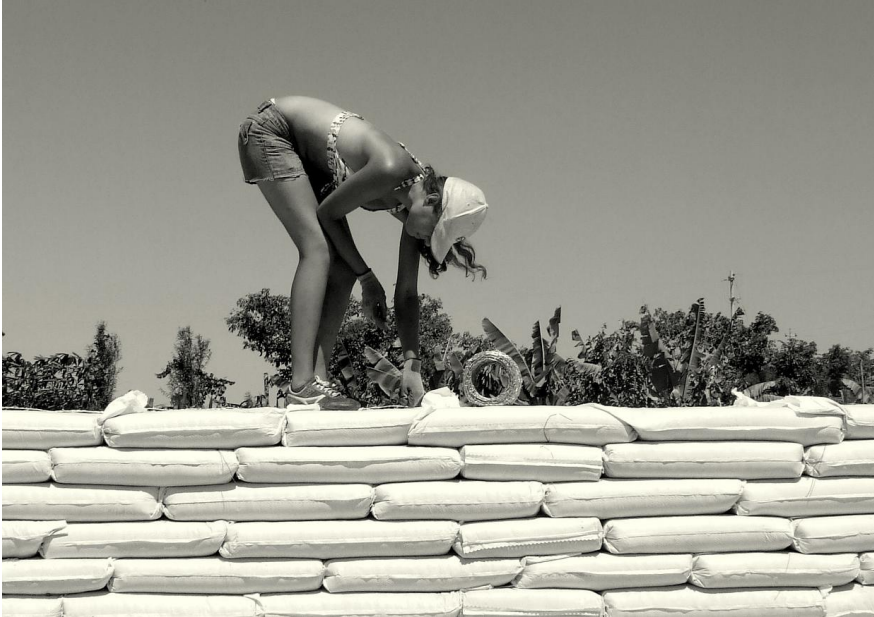
Fig.3.45.-Joven voluntaria coloca de alambre de púas entre cada hilada de sacos para dar mayor rigidez a l muro.
