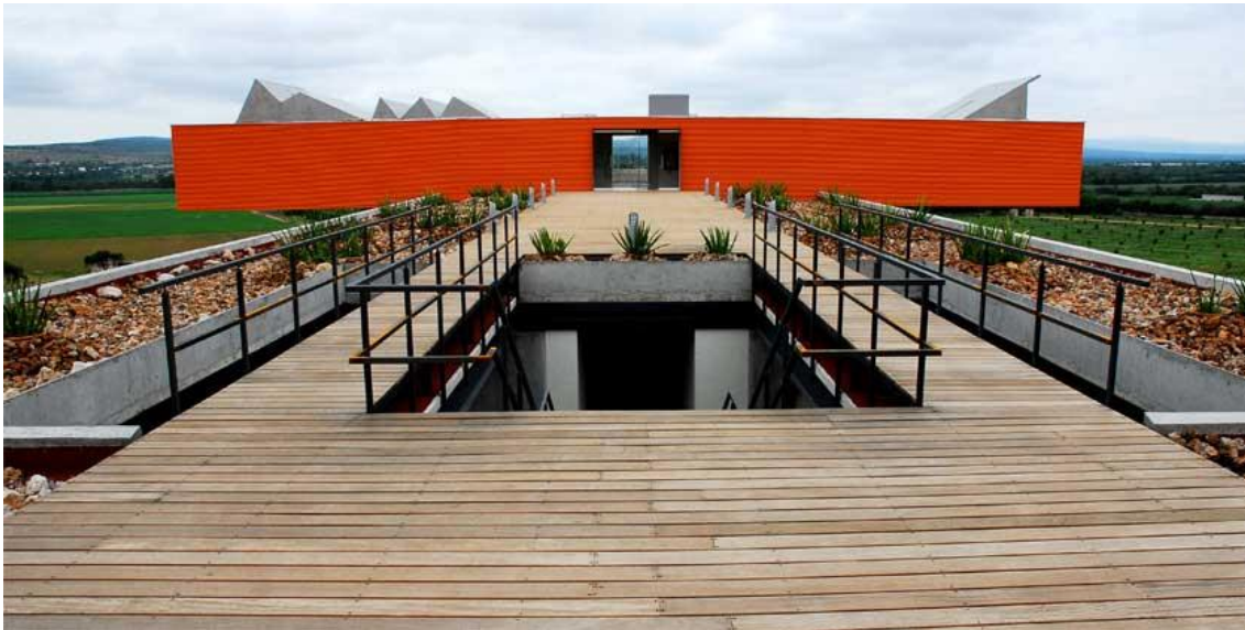
Ilustración 3. Vista de la explanada. Fotografía: (Broid, 2013).
