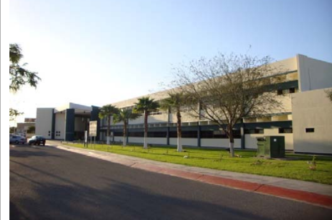
Imagen 1.71: Fachada de la escuela de medicina Fuente: Archivo propio
