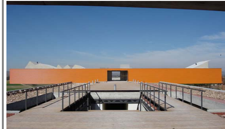
Imagen 1.61: Vista del andador exterior Fuente: http://www.plataformaarquitectura.cl
