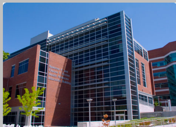
Imagen 1.44: Fachada del edificio de ciencias de la salud de la universidad de Utah Fuente: http://medicine.utah.edu/alumni/images/hseb%20photo.jpg
