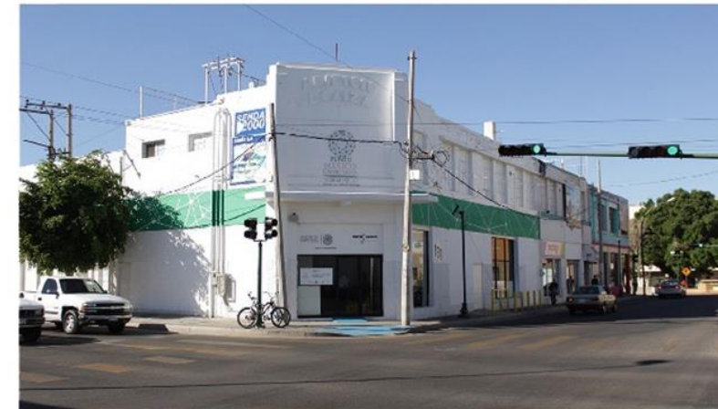
IMG 04 - Apariencia actual del Edificio Loaiza
