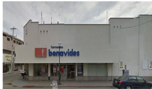
IMG 01 - Fachada Norte(1)
