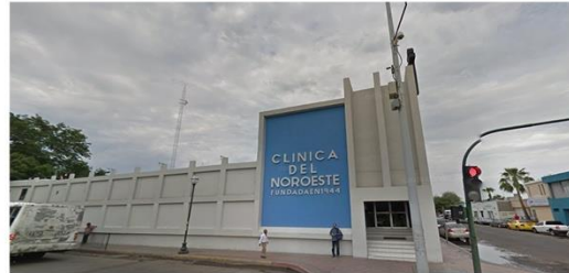
IMG 01 - Fachada principal (1)
