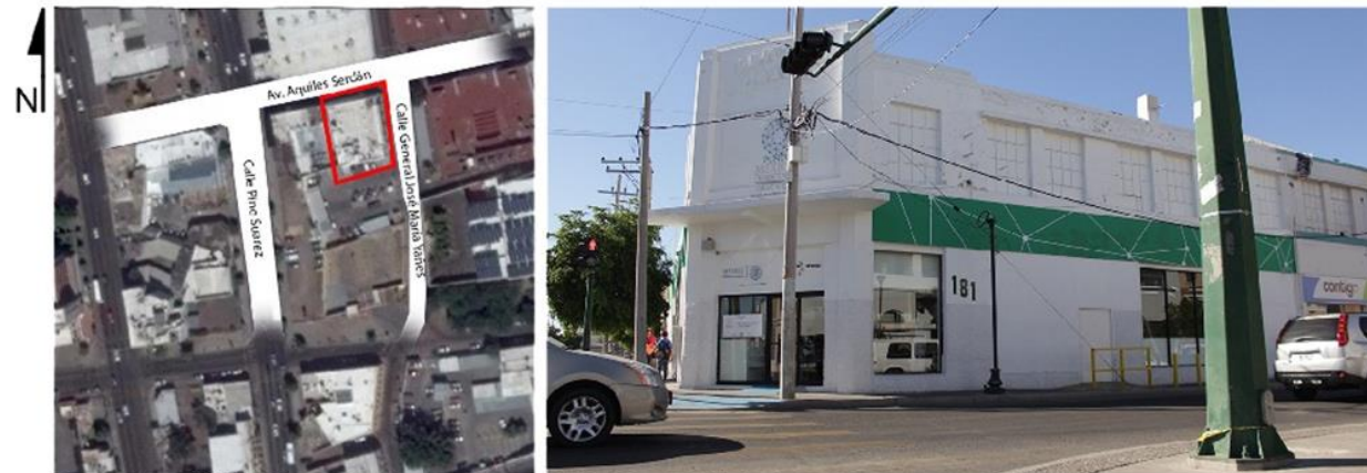
IMG 01 - Ubicación Edificio Loaiza IMG 02 - Edificio Loaiza
