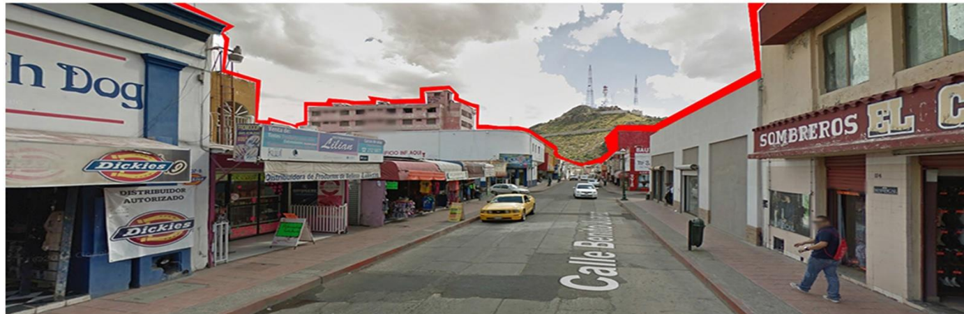
IMG 02 - Vista hacia el Sur
