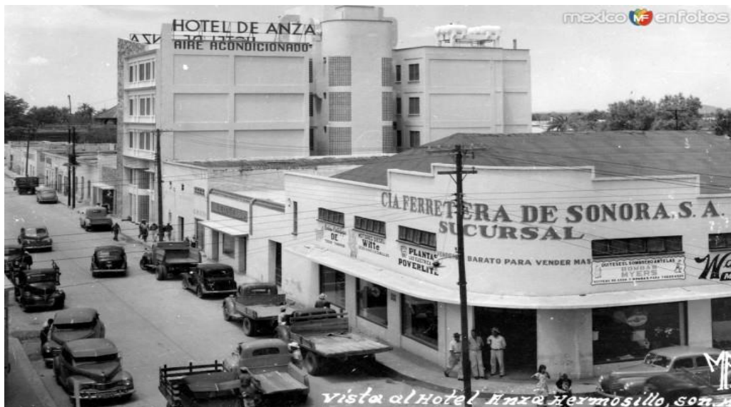
IMG 2.07 - Hotel de Anza 38 Ubicación: Calle Plutarco Elías Calles, Col. Centro HERMOSILLO, SONORA, MÉXICO
