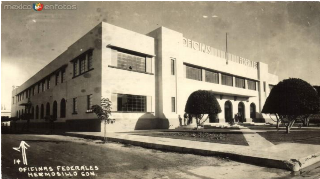
IMG 2.03 Correos de México 34 Ubicación: Av. Aquiles Serdán y calle Av. Rosales No. S/N, Col Centro HERMOSILLO, SONORA, MÉXICO
