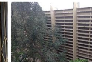
IMG 08 - Detalle de Ventanas
