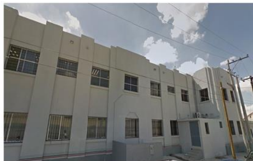
IMG 03 - Fachada Norte (4)
