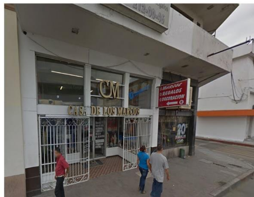
IMG 02 - Entrada secundaria de fachada Norte (2)
