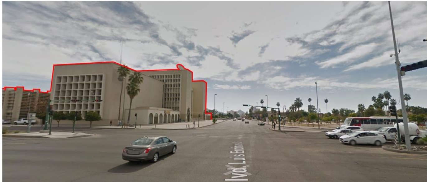
IMG 02 - Vista hacia el Sur
