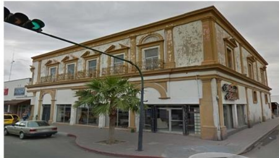
IMG 01 - Mueblería México (1)
