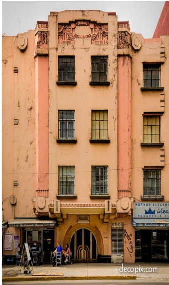
IMG 1.09 Detalles de torres verticales, geometrías y decoraciones esculpidas, esquinas en terminado angular, entrepaños escalonados y ventanería de bastidores de acero 18
