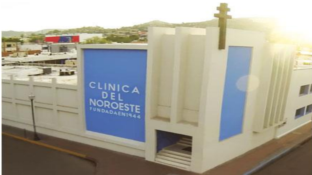
IMG 2.06 - Clínica del Noroeste 37 Ubicación: Av Luis Donaldo Colosio y calle Benito Juárez, Col. Centro HERMOSILLO, SONORA MÉXICO
