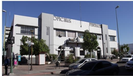
IMG 01 - Vista desde la Av Aquiles Serdán (1, 2, 3, 4)
