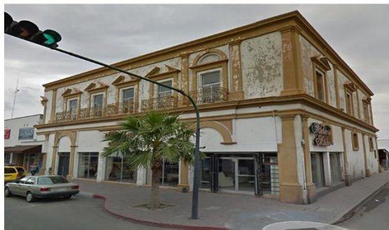
IMG 05 - Mueblería México (5)
