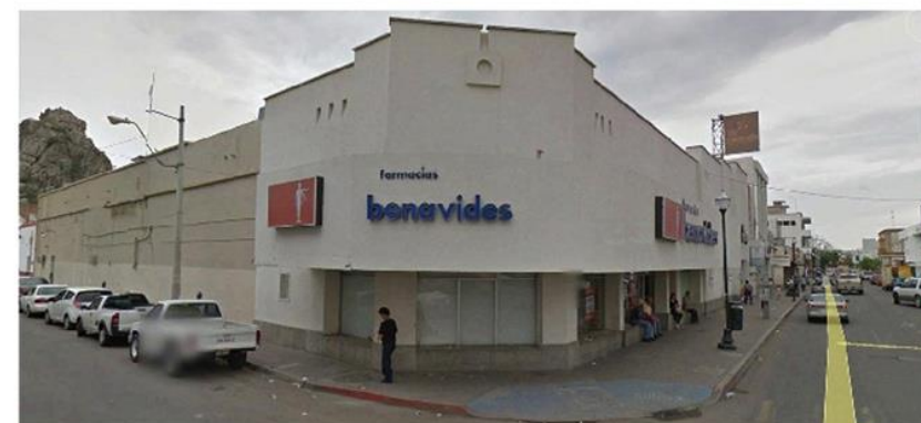
IMG 04 - Apariencia original edificio Morales Hnos
