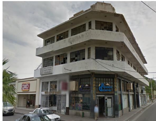
IMG 01 - Fachada Norte (1)
