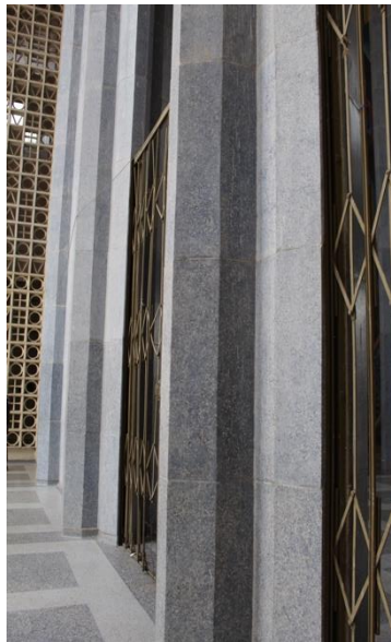
IMG 2.33 Detalle de columnas del edificio Museo Biblioteca 75 HERMOSILLO, SONORA, MÉXICO
