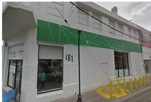
IMG 02 - Fachada Norte (2)
