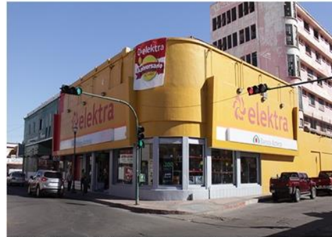
IMG 01 - Vista desde intersección de Calle Benito Juárez y Av Plutarco Elías Calles
