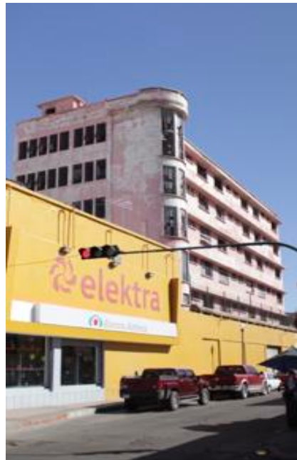
IMG 2.40 Hotel Laval 86 HERMOSILLO, SONORA, MÉXICO
