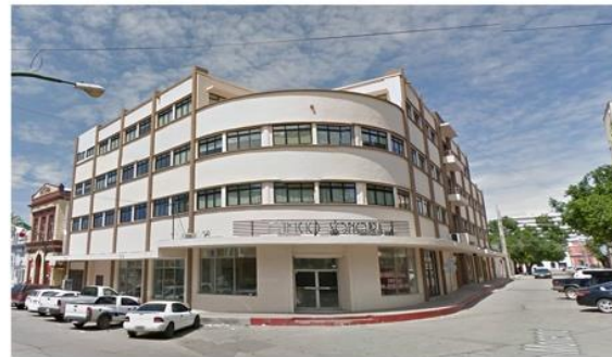
IMG 04 - Edificio Sonora (4)
