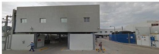
IMG 05 - Entrada a estacionamiento (6, 7)
