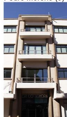
IMG 06 - Entrada secundaria (3)
