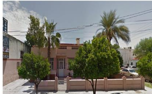
IMG 01 - Fachada Norte (1)
