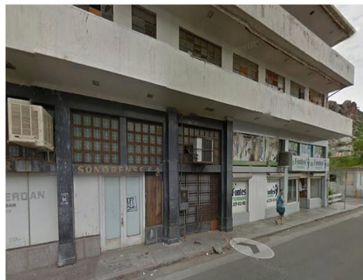
IMG 03 - Fachada Oeste (3,4,5,6)
