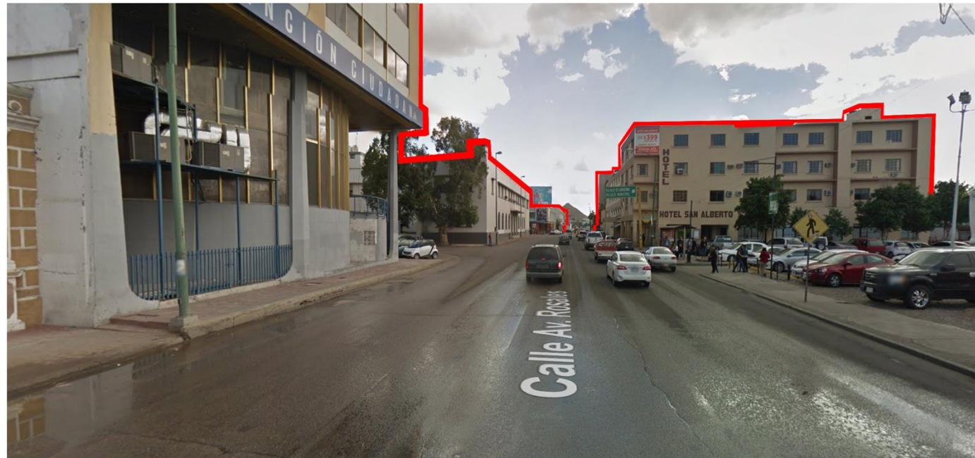
IMG 01 - Vista hacia el sur
