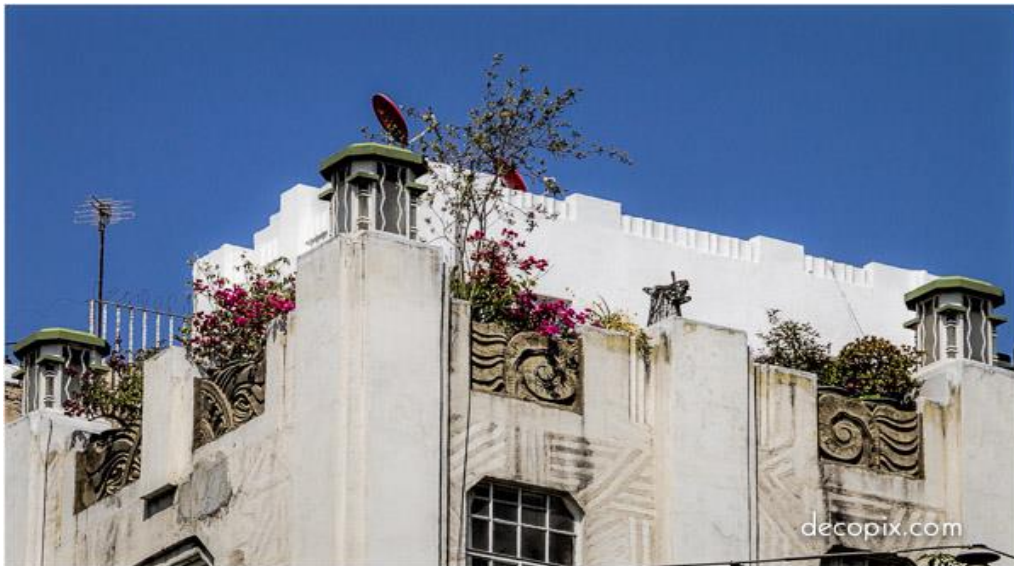
IMG 1.08 Detalles de torres verticales, geometrías y decoraciones esculpidas, esquinas en terminado angular, entrepaños escalonados y ventanería de bastidores de acero 17
