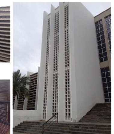
IMG 10 - Detalles de elementos verticales
