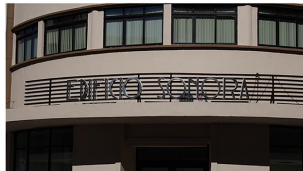
IMG 05 - Edificio Sonora (5)
