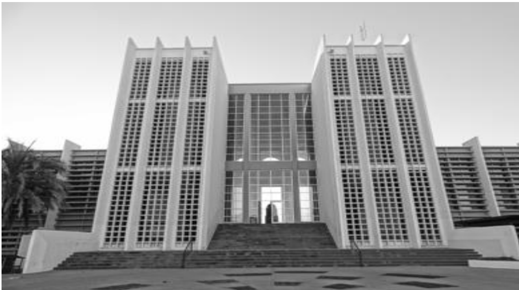
IMG 2.31 Edificio Museo Biblioteca de la Universidad de Sonora 73 HERMOSILLO, SONORA, MÉXICO
