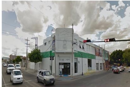
IMG 01 - Entrada principal (1)
