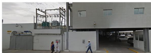
IMG 04 - Entrada al estacionamiento (5, 6)
