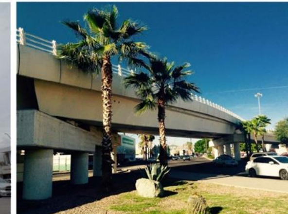
IMG 12 - Puente Trébol
