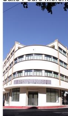
IMG 05 - Entrada principal (1)
