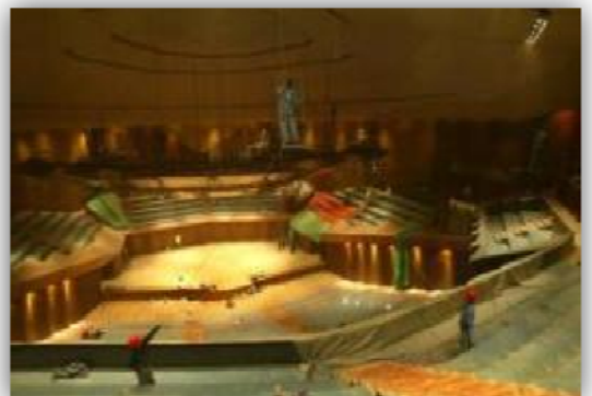
Fig. 1.41 Trabajos de remodelación en 2010. Fuente: blogspot.com.
