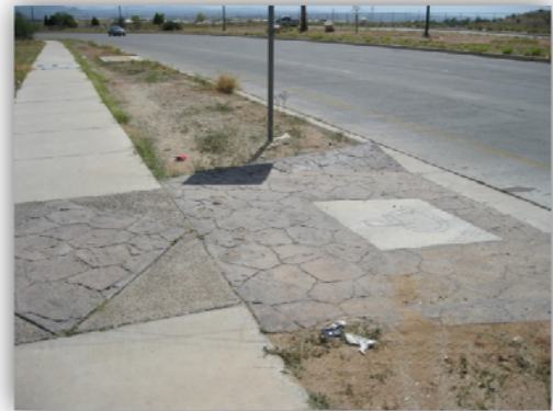
Fig. 1.29 Accesibilidad en banqueta. Archivo propio.
