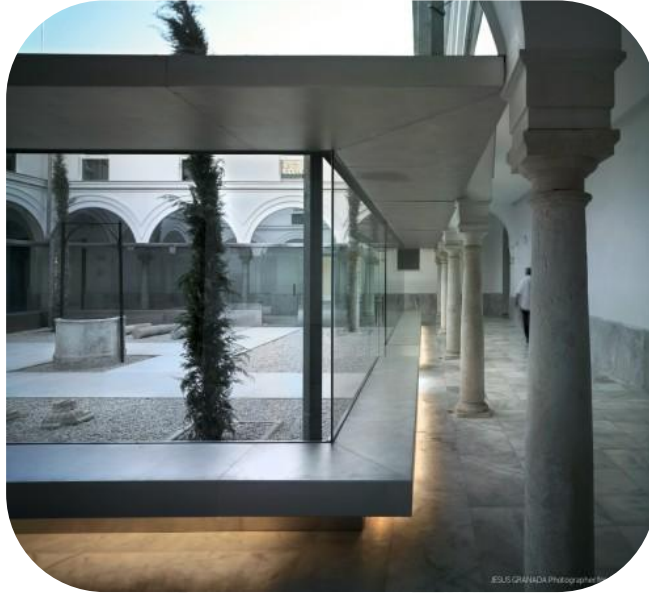
Imagen 24 Hospital San Jerónimo Fuente: SV60 Arquitectos
