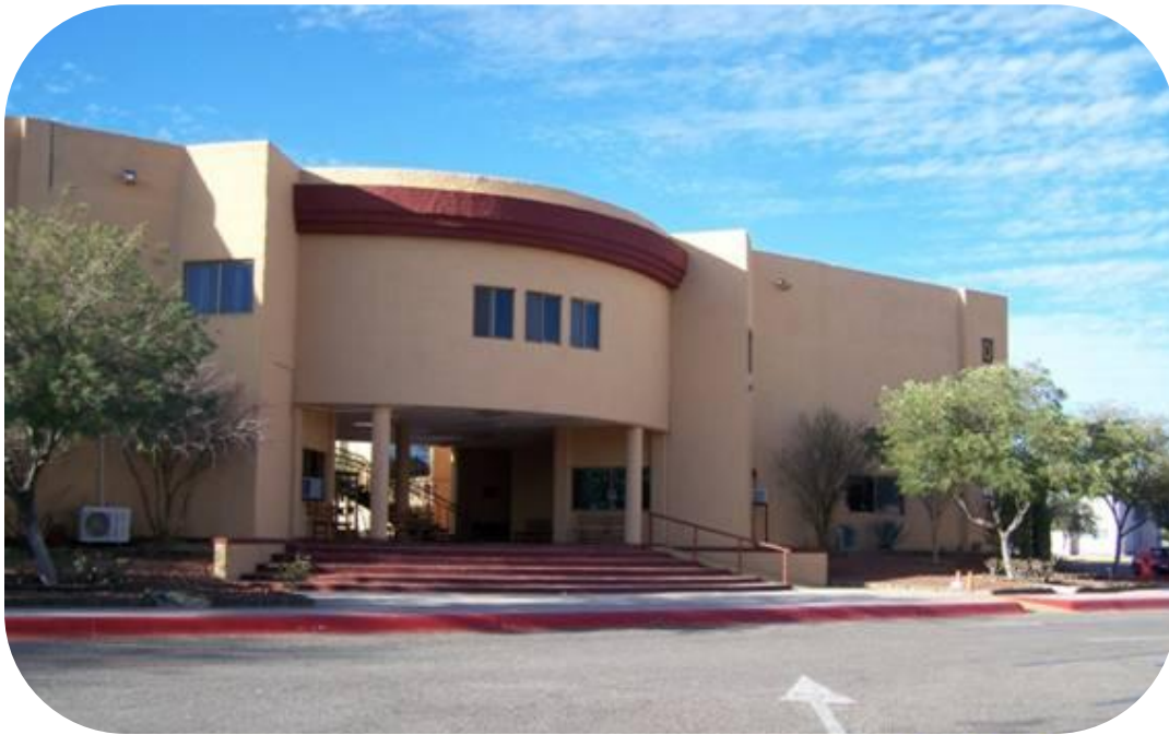
Imagen 15 Fachada. Acceso principal al Centro. Fuente: CIAD
