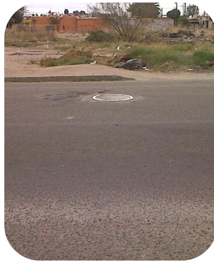
Fotografía 9 Servicios de alcantarillado. Fuente: Elab. Propia
