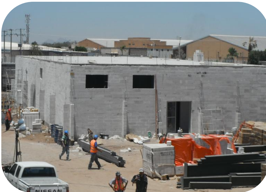
Imagen 29 Sistema de envoltente Hebel. Fuente: Elaboración propia
