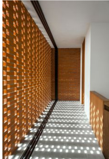
Fotografía 3.2 Celosías en interior de edificio. Fuente Archdaily.mx.
