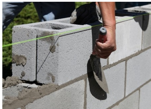
Fotografía 5.2. Aplicación de sistema constructivo a base de block de cemento. Fuente pcg.wireconsultinggroup.com
