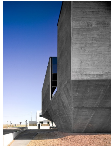
Fotografía 2.2 Volumetría en edificio. Fuente Archdaily.mx.
