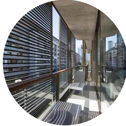
Imagen 32: Protecciones solares.
