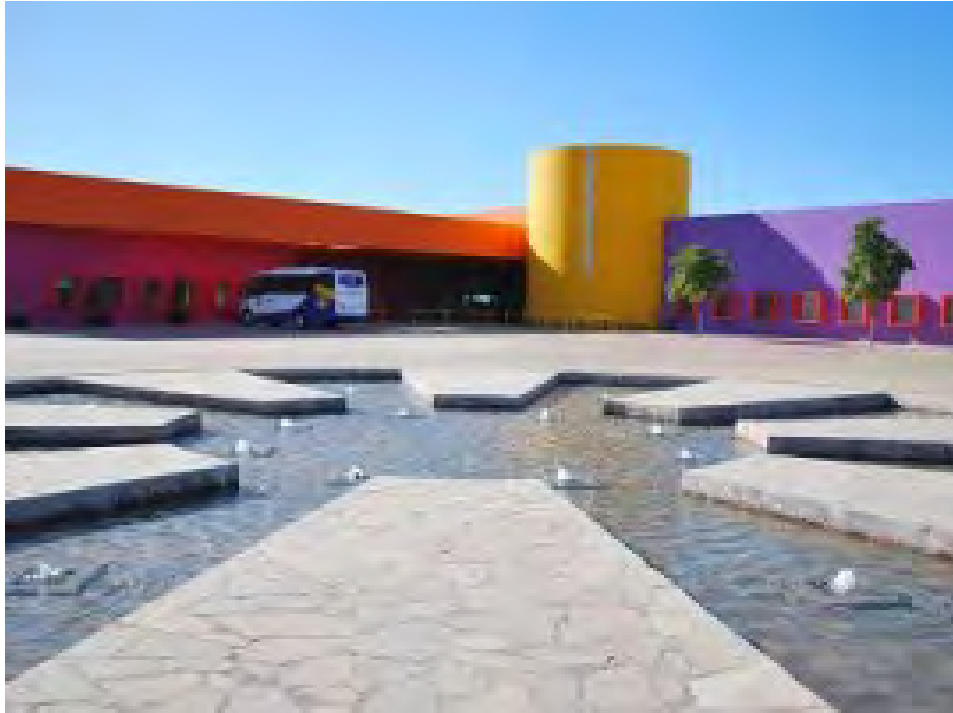
Imagen 70: Fachada principal. Fuente: M.B.A.G.
