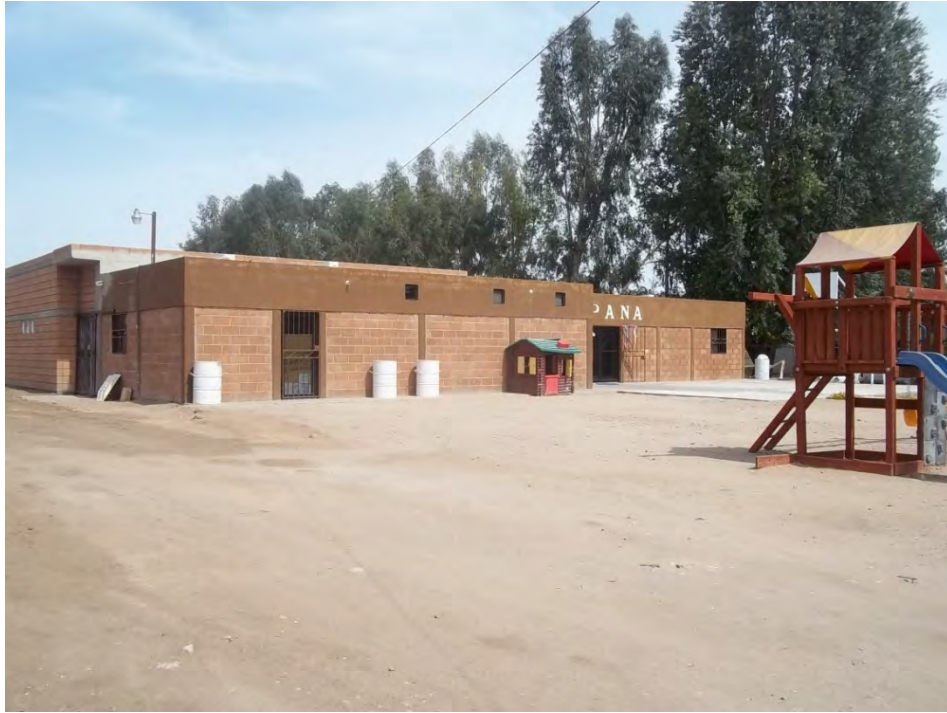
Imagen 37. Fachada principal. Fuente: M.B.A.G.
