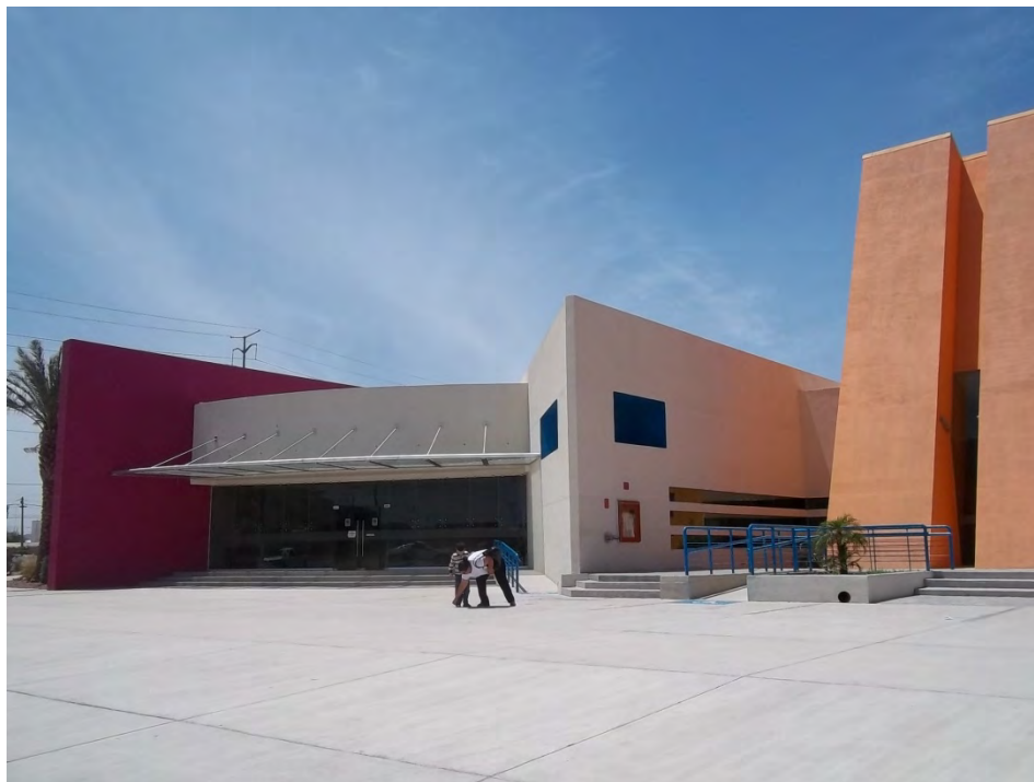
Imagen 32. Fachada Principal. Fuente: B.L.U.L.
