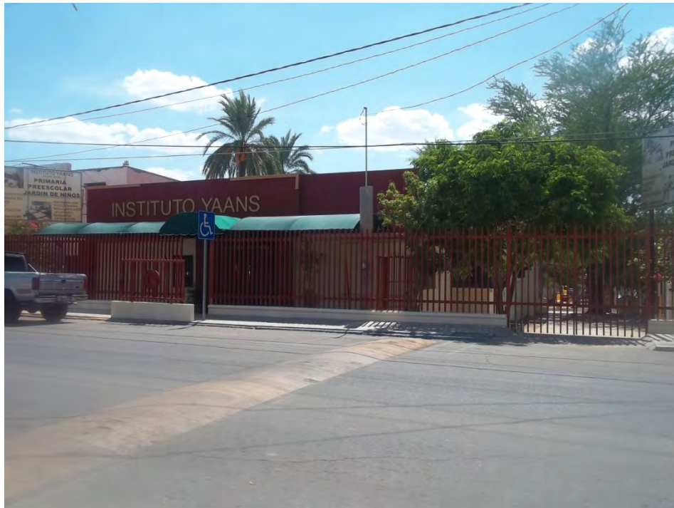
Imagen 67. Fachada Principal. Fuente: B.L.U.L.
