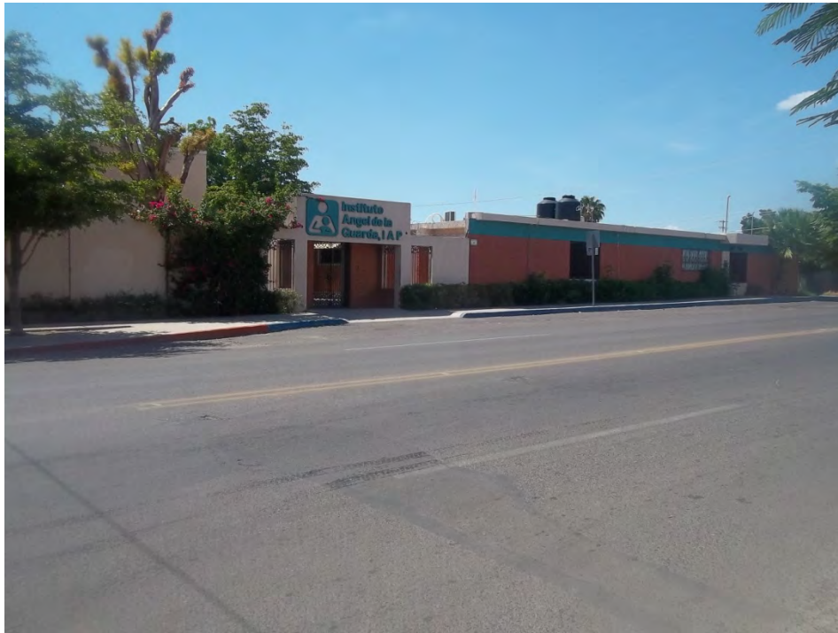
Imagen 50. Fachada principal. Fuente: B.L.U.L.
