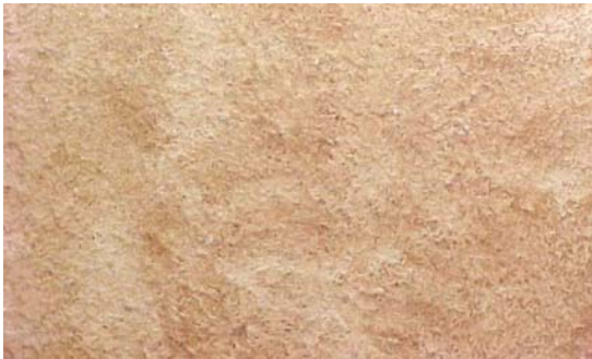
Fotografía 2.9 Acabado muro exterior. Obtenido de internet.
