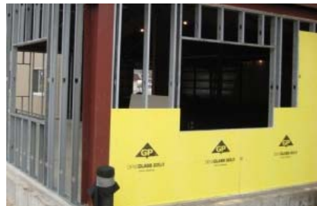
Fotografía 2.4 Aplicación denssglas en obra. Obtenido de internet.
