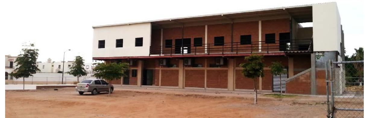
Fotografía 1.1. El terreno, vista hacia el edificio existente. Fuente archivo propio. Fecha 15/04/2014
