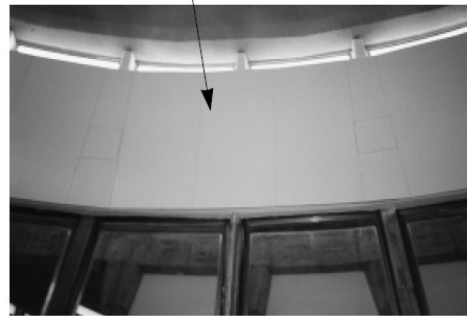
Fig. 2.1.39 Resonador de membrana instalado en la sala de actos de la Torre de Telecomunicaciones de Telefónica, Barcelona (España); M = 4,8 Kg/m 2 ; d = 5 cm; cavidad con lana de roca de 30 mm de espesor y 40 Kg/m 3 de densidad. creado es de membrana. A continuación se presentan unos ejemplos ilustrativos.
