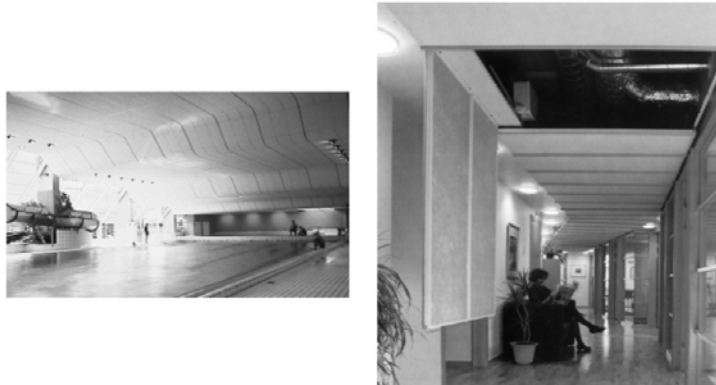
Fig. 2.1.32 Ejemplos de montaje de los paneles de la figura 3.2.67
