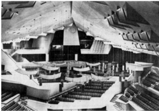
Fig. 2.1.46 Vista del techo de la BerlinPhilharmonie (Alemania) con los resonadores simples de cavidad (Helmholtz) incorporados.
