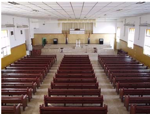
1.3 Vista desde área de mezzanine, se alcanzan a apreciar las grandes ventanas a ambos lados de la nave, las cuales aportan una enorme ganancia de calor al recinto al no contar con un cristal adecuado que minimice el paso del mismo.
