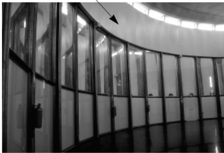
Fig. 2.1.39 Resonador de membrana instalado en la sala de actos de la Torre de Telecomunicaciones de Telefónica, Barcelona (España); M = 4,8 Kg/m 2 ; d = 5 cm; cavidad con lana de roca de 30 mm de espesor y 40 Kg/m 3 de densidad. creado es de membrana. A continuación se presentan unos ejemplos ilustrativos.
