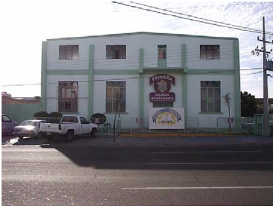
1.5 Vista fronta del edificio. A lado izquierdo de la imagen se observa el portón que da acceso al área sin construcción que se pretende utilizar para la expansión del proyecto.
