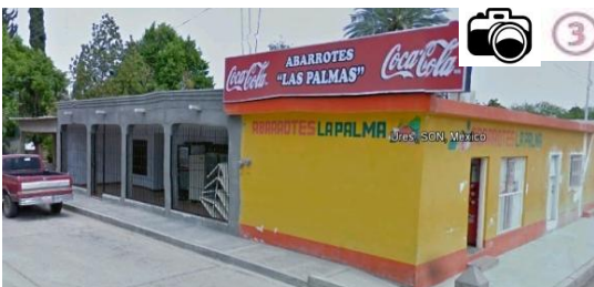
Fotografía 1.11 Zona habitacional y de servicios S/E. Fuente: Archivo propio.
