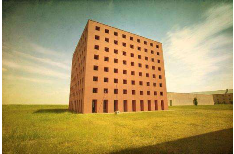
Fotografía 16. Edificio de nichos. Fuente: ArchDaily
