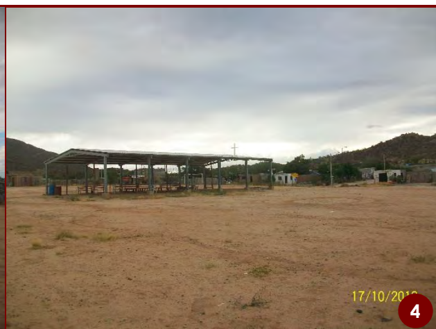
Imagen 44. Vista 4 de terreno III. Fuente: Reserva de Archivos Personales.
