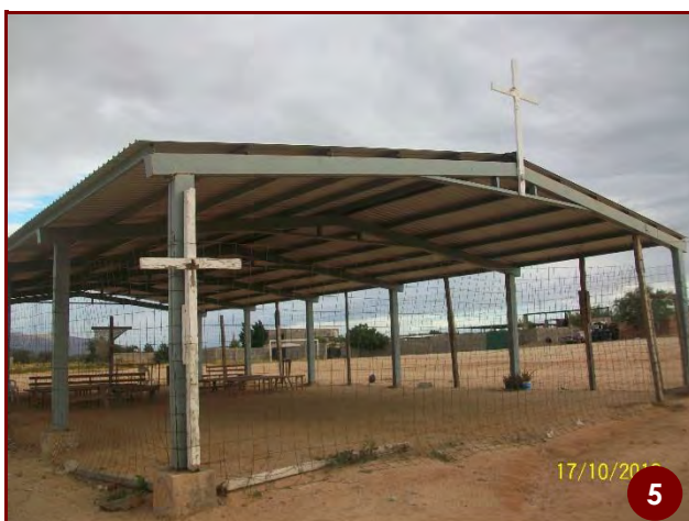
Imagen 45. Vista 5 de terreno III. Fuente: Reserva de Archivos Personales.
