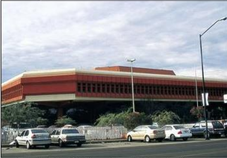
Fotografía de Casa de la Cultura en Hermosillo. Fuente: Google Imágenes
