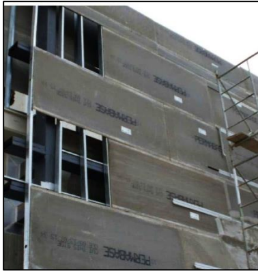
Imagen 1: Muro de yeso PERMSABAE para exterior
