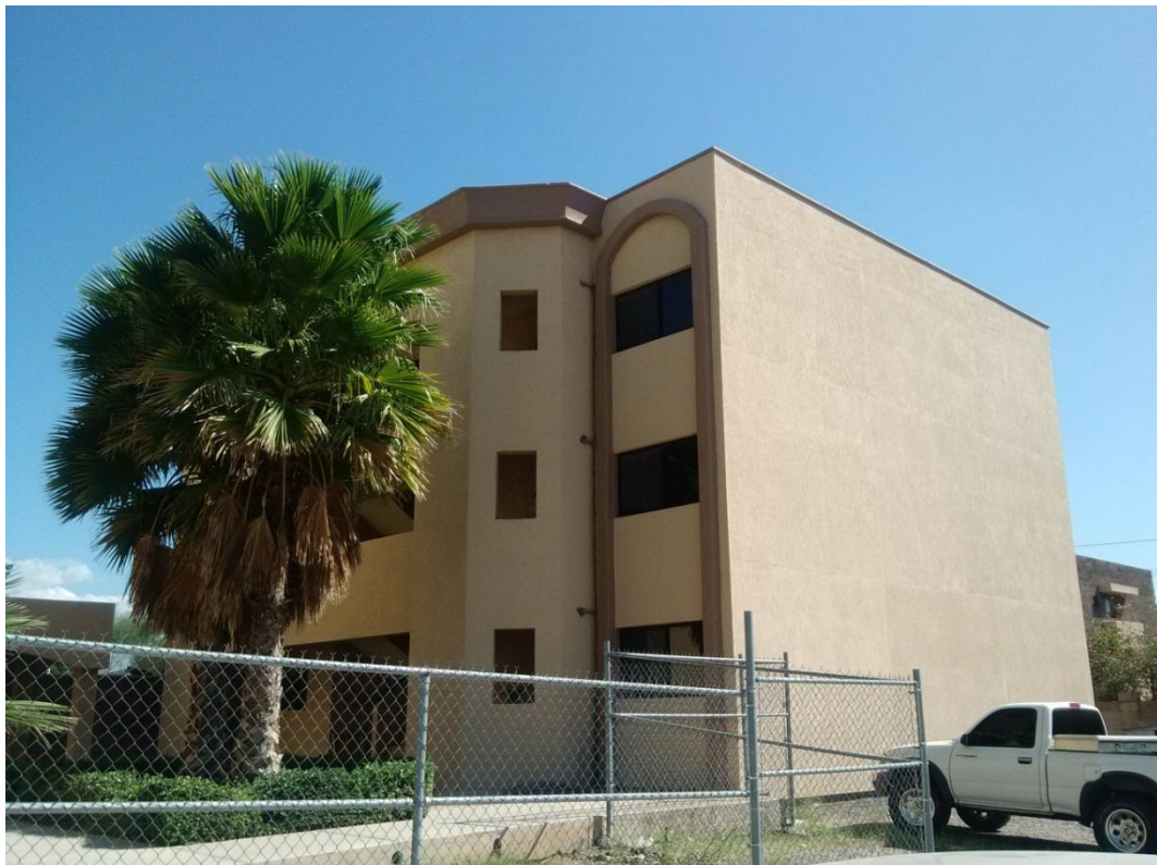
Fotografía 1. Perspectiva general de bloque 3 (Archivo personal: Carlos Barriga R.)
