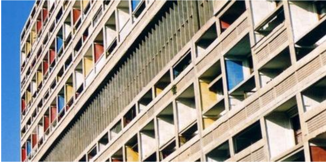
Imagen 2 Edificio Unidad Habitacional Marsella, Mies Van der Rohe( http://snobberyfields.blogspot.mx/2011/07/unite-d-habitation-marseilles.html )
