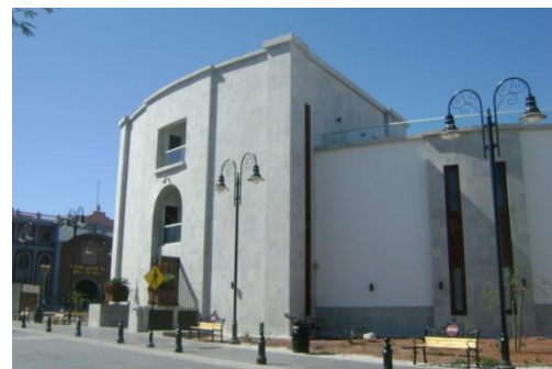
Figura 2.23. Edificio Bicentenario. (Fachada Posterior. Fuente: Propia
