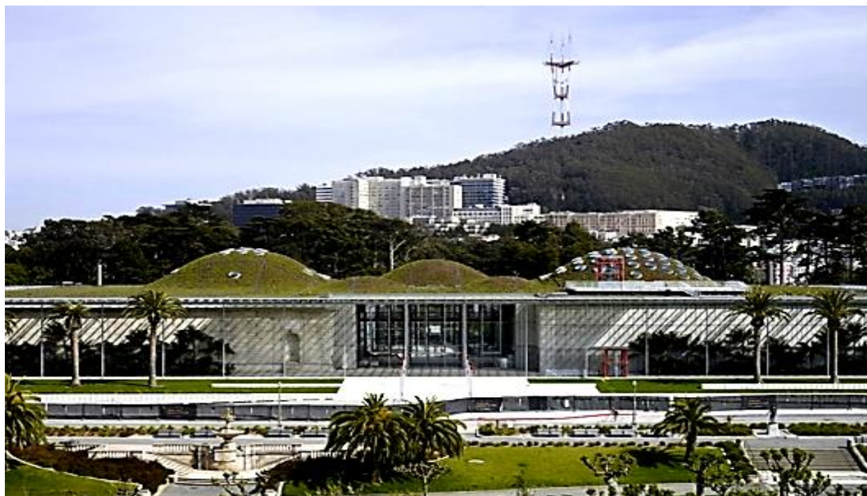
FOTOGRAFIA 9. ACADEMIA DE LAS CIENCIAS DE CALIFORNIA. Ubicado en el Golden Gate Park, California. Fuente: www.wikiarquitectura.com
