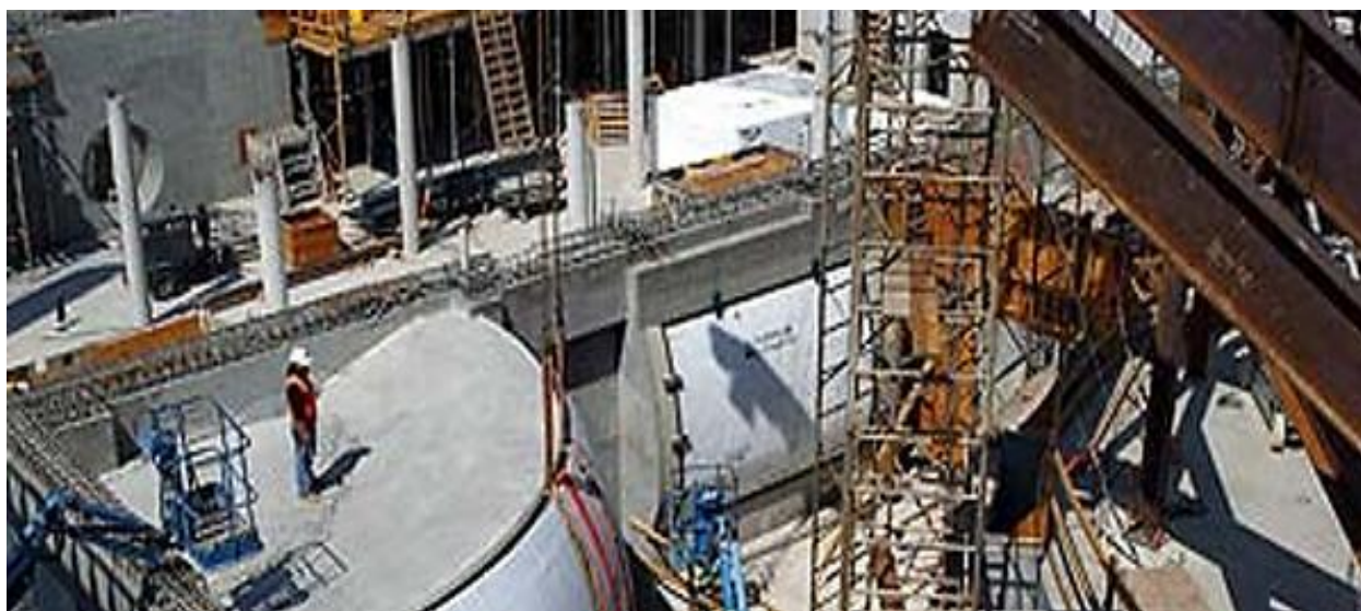
FOTOGRAFÍA 19. SISTEMAS CONSTRUCTIVOS DE ACADEMIA DE LAS CIENCIAS DE CALIFORNIA. Constructores trabajando en muros de concreto para el acuario y detalle de la colocación de las vidrieras de acrílico. Fuente: http://www.calacademy.org
