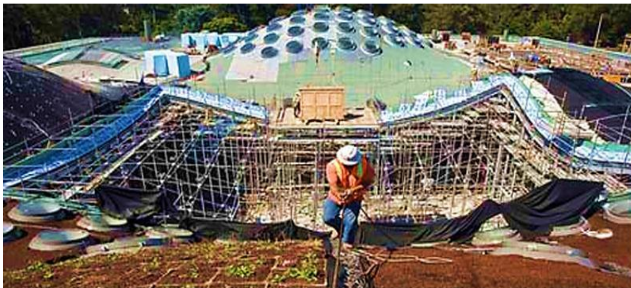
FOTOGRAFÍA 18. SISTEMAS CONSTRUCTIVOS DE ACADEMIA DE LAS CIENCIAS DE CALIFORNIA. Constructores trabajando en claraboyas en azotea. Fuente: http://www.calacademy.org
