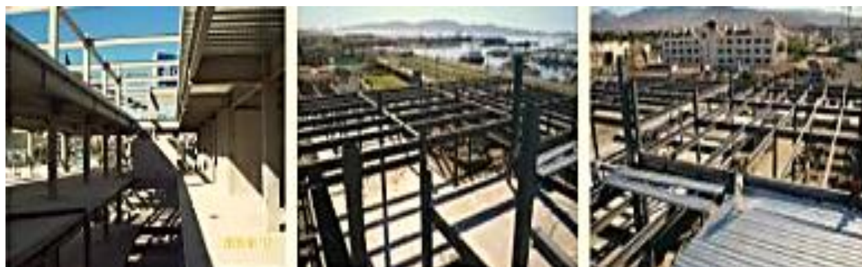
FOTOGRAFÍAS 21,22 Y 23. SISTEMAS CONSTRUCTIVOS DE CARACOL, MUSEO DE CIENCIAS Y ACUARIO. Detalles de los marcos rígidos de la estructura metálica y entresijos de steel deck (losa acero). Fuente: www.caracol.org.mx
