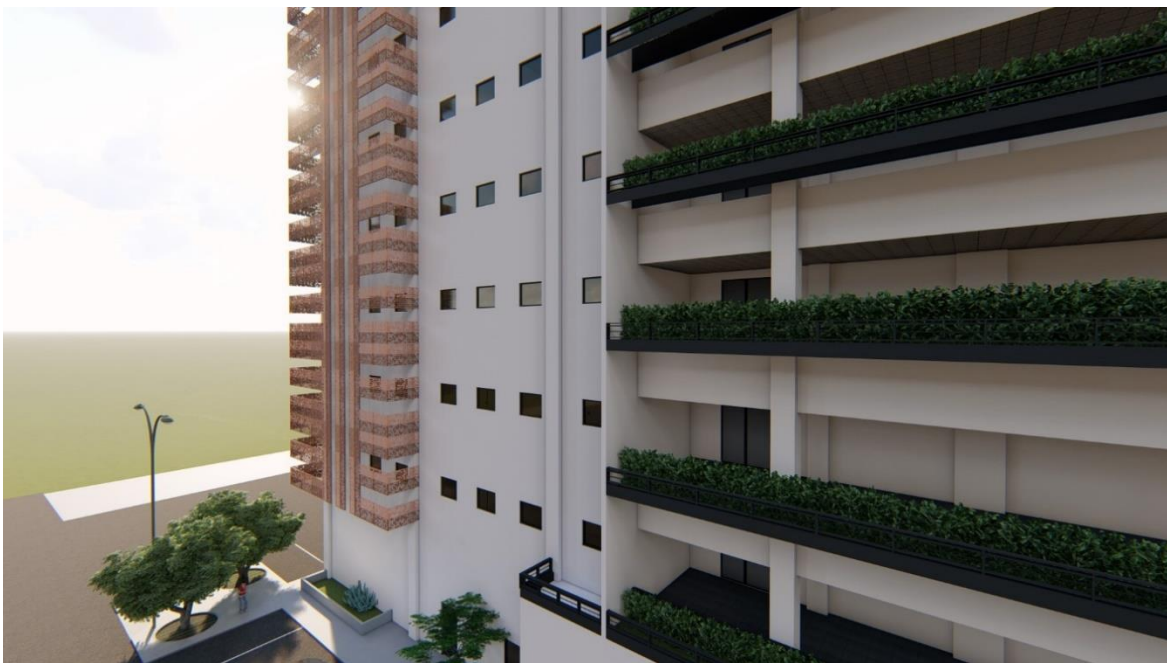
IMAGEN 53. Perspectiva de terrazas en fachada este. Fuente: propia, (2018).
