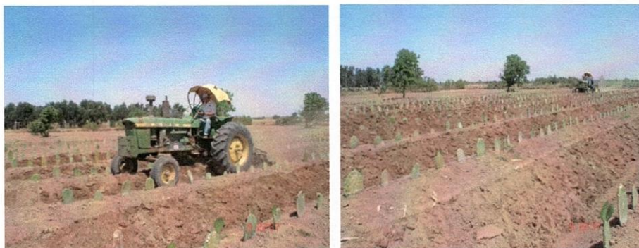
Figura 2. Preparación de terreno
