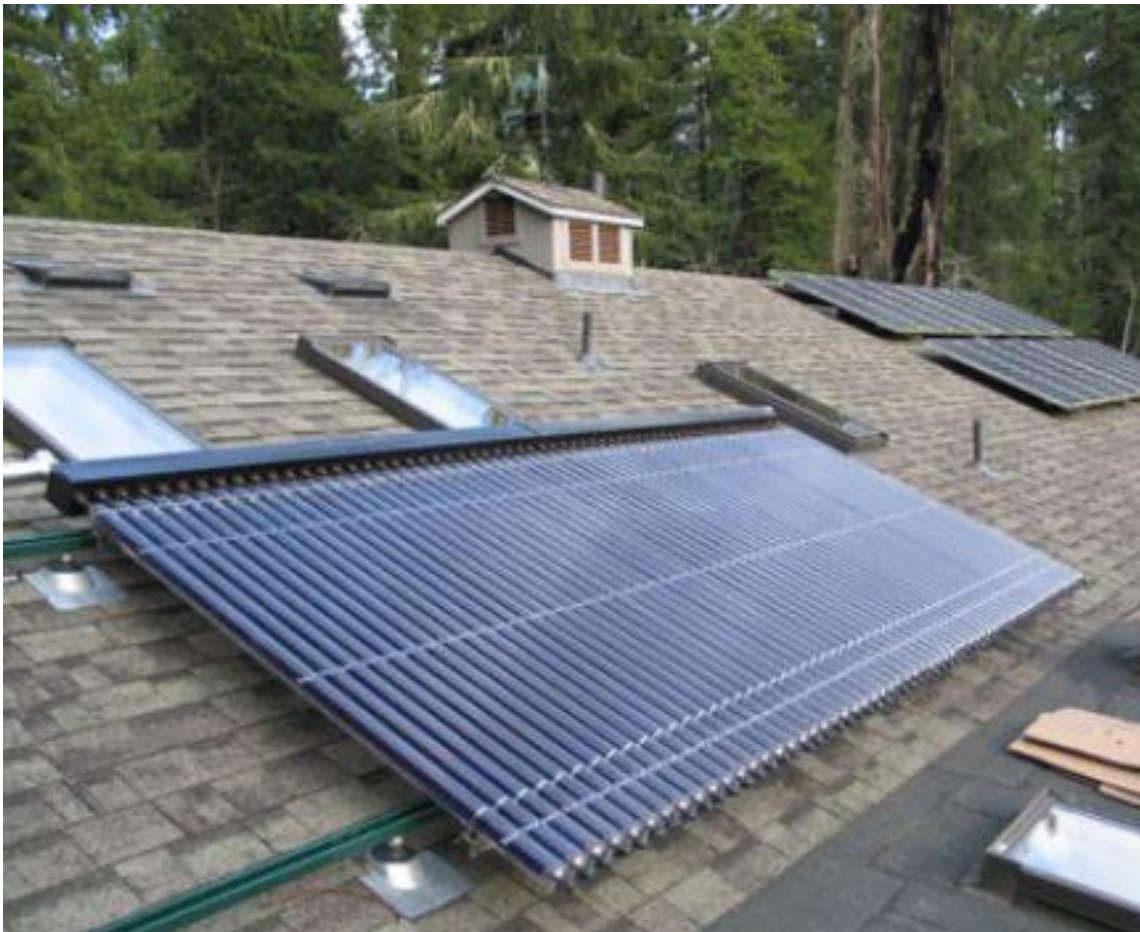
Figura 2.1 Colector solar sin concentración para calentamiento de agua.
