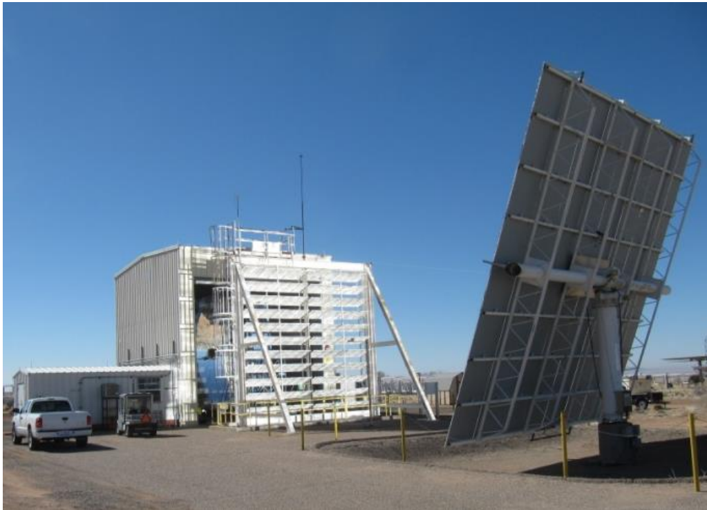
Figura 2.5 Horno solar ubicado en los Laboratorios Nacionales Sandia, Estados Unidos.
