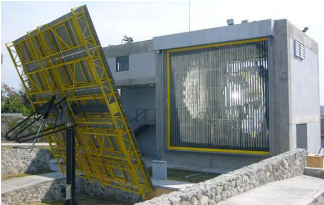
Figura 2. 7 Horno solar del Instituto de Energías Renovables, México.
