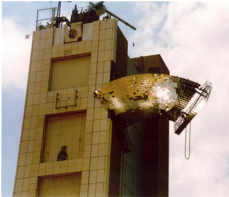
Figura 2.9 Concentrador hiperbólico del horno solar en el Instituto Weizmann, Israel.
