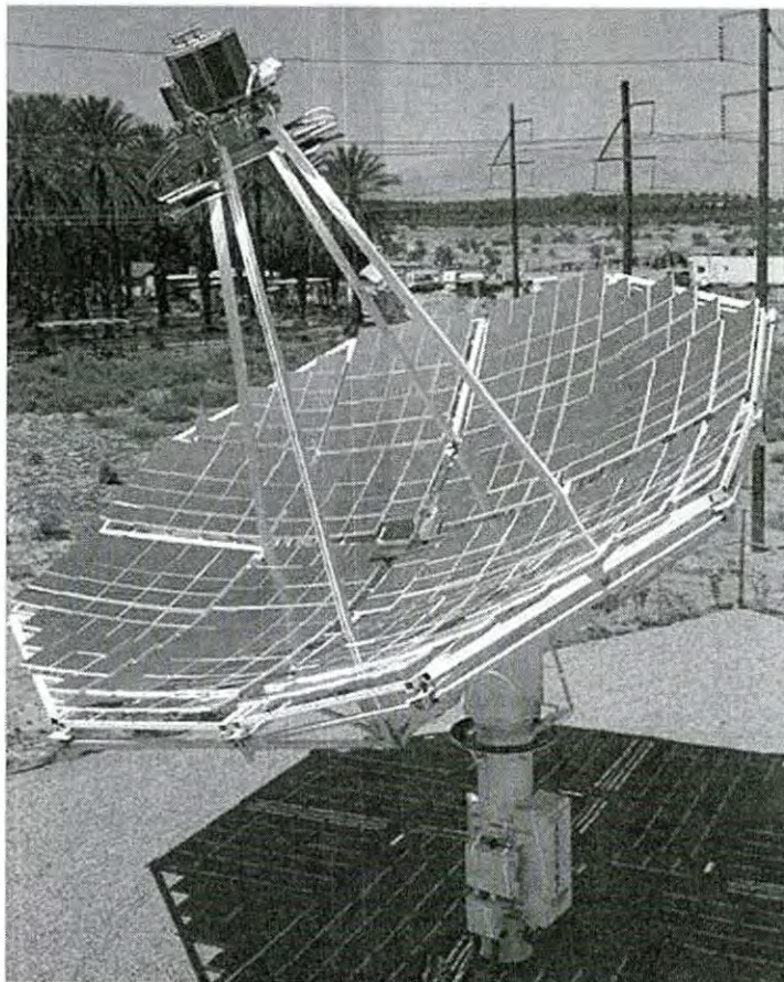
Figura 2 Concentrador solar de plato parabólico con motor térmico Stirling.
