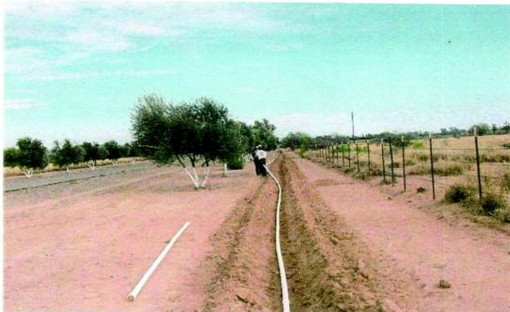
Figura 1. Instalación de la línea de conducción que llevó el agua de la pila al área de estudio.
