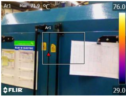
Figura 16 . Hornos con control de temperatura y periodos de funcionamiento (Furukawa).
