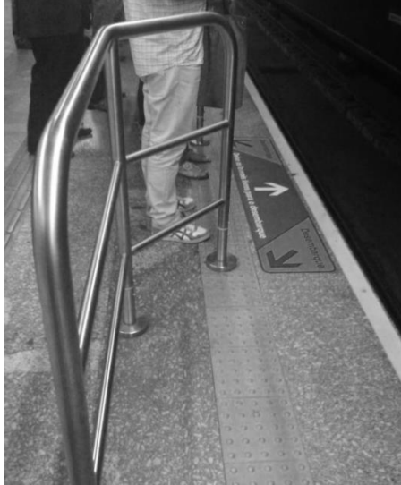
Imagen 6.3 Pasamanos separador de flujo de ascenso-descenso en el metro de la ciudad de San Pablo, Brasil.
