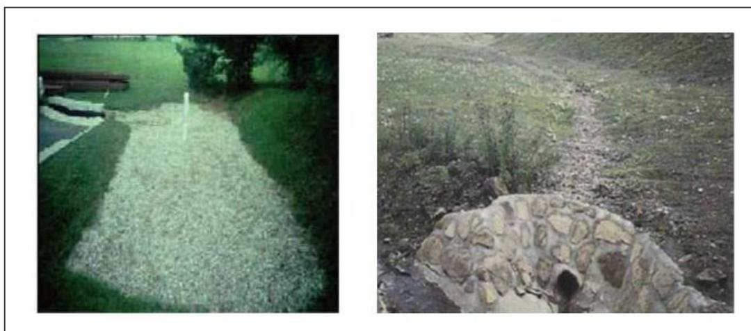
**Fig. 6 Pozo y zanja de filtración con superficie de grava**
