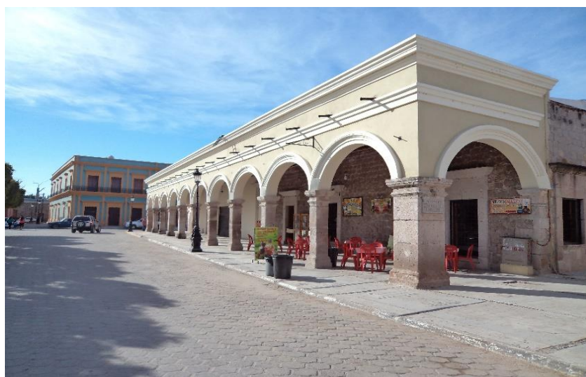
Figura 27: Fachada restaurada y pintada
