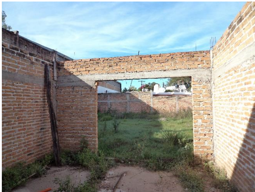
Figura 29: Interior de un domicilio restaurado en exterior
