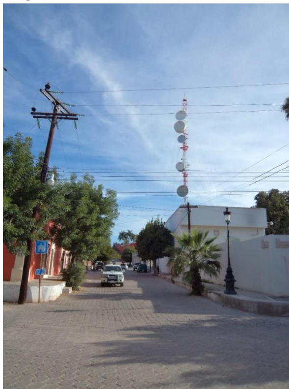
Figura 37: Cableado de la ciudad de El Fuerte
