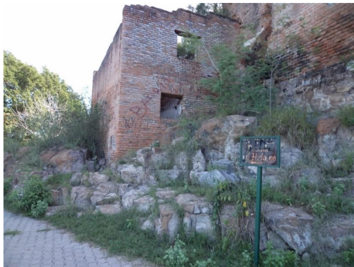
Figura 15: Construcción en ruinas vandalizada en el Malecón del Río fuerte
