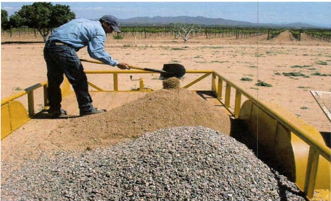
Fotografía 2. Preparación del sustrato grava/arena en una proporción aproximada de 1:1 para llenar pozos de infiltración
