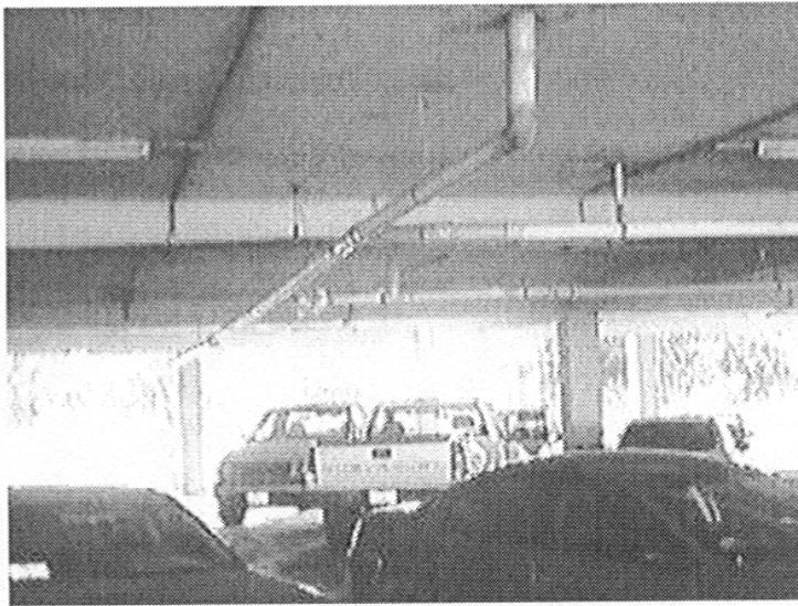
Figura 11 Descarga de la fuente y aguas pluviales.
