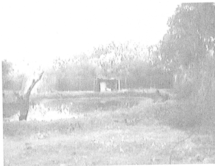
Figura 15 Campo de oxidación y caseta de clorinación.
