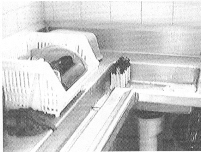
Figura 1 Canaleta de lavado.
