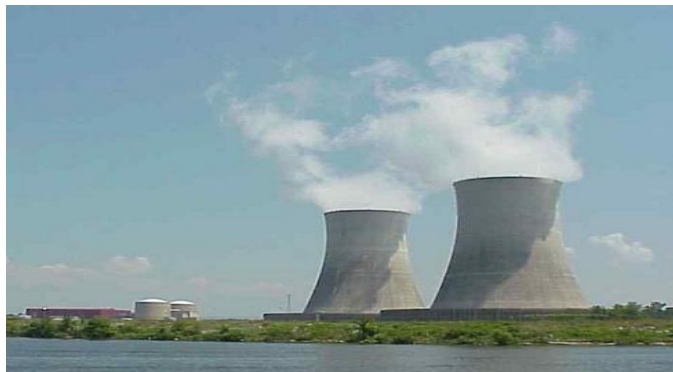
Figura 1. Planta generadora de energía nuclear (Muñoz, 2010).
