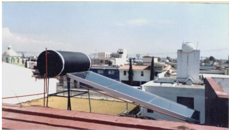
Figura 5. Calentador solar de agua (Solar Technology)
