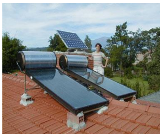
Figura 2.13. Tecnología solar activa de baja temperatura.
