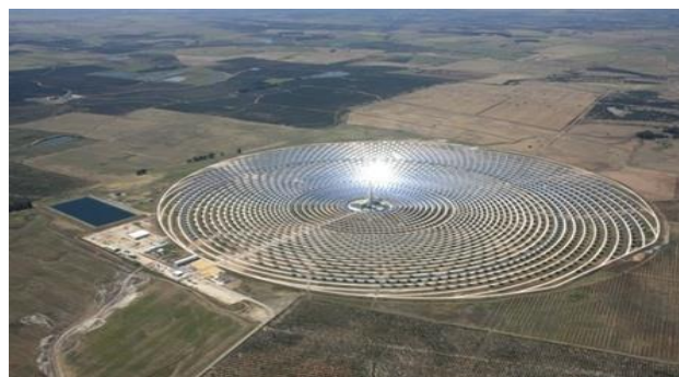
Figura 2.35. Campo solar: 2,650 helióstatos en 185 hectáreas.
