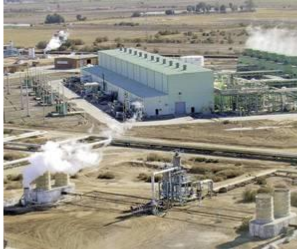
Figura 2.7. Planta Geotermoeléctrica Cerro Prieto, Baja California, México.
