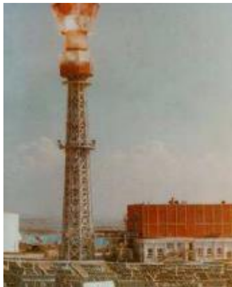
Figura 2.32. Planta termosolar SSPP-5.
