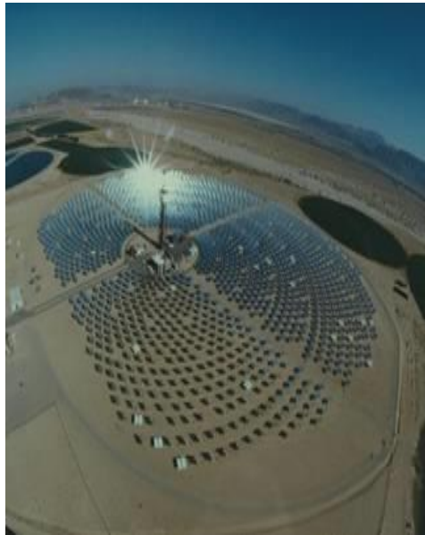
Figura 2.31. Planta termosolar Solar Two.
