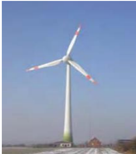
Figura 2.6. Aerogenerador de eje horizontal de tres palas.
