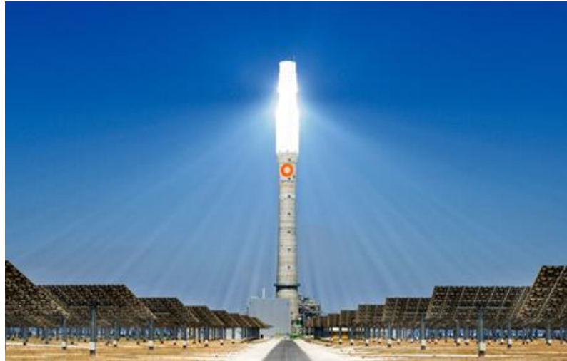
Figura 2.34. Planta Termosolar Gemasolar en Fuentes de Andalucía, Sevilla, España.
