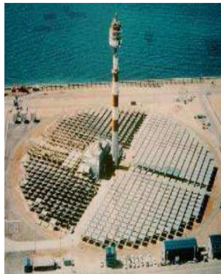
Figura 2.29. Planta termosolar Sunshine.
