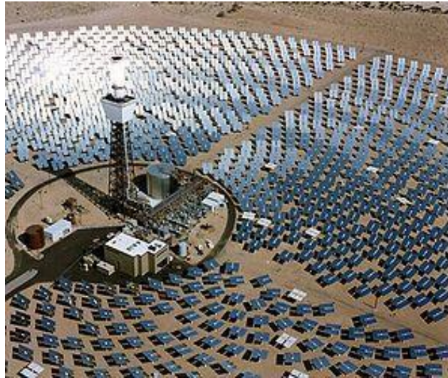
Figura 2.27. Concentradores de helióstatos y torre central de la Planta Solar One, en Barstow, California.
