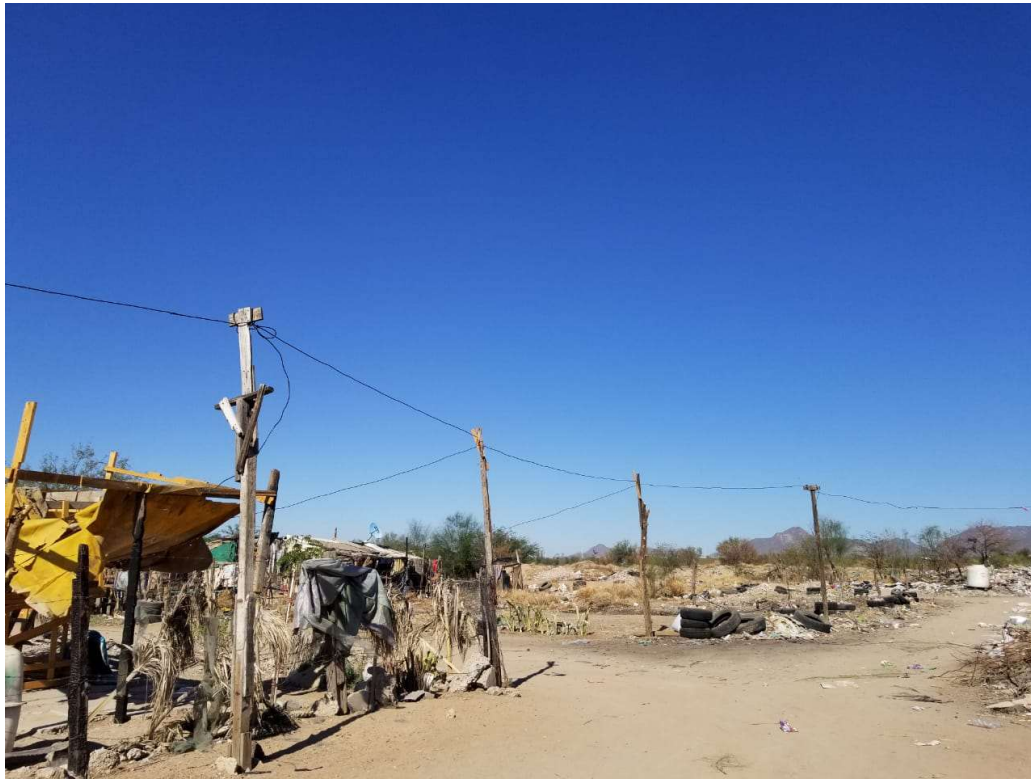
Figura 8.1 Imagen de calle y cableado colonia “Invasión Guayacanes”. Fuente: Propia.
