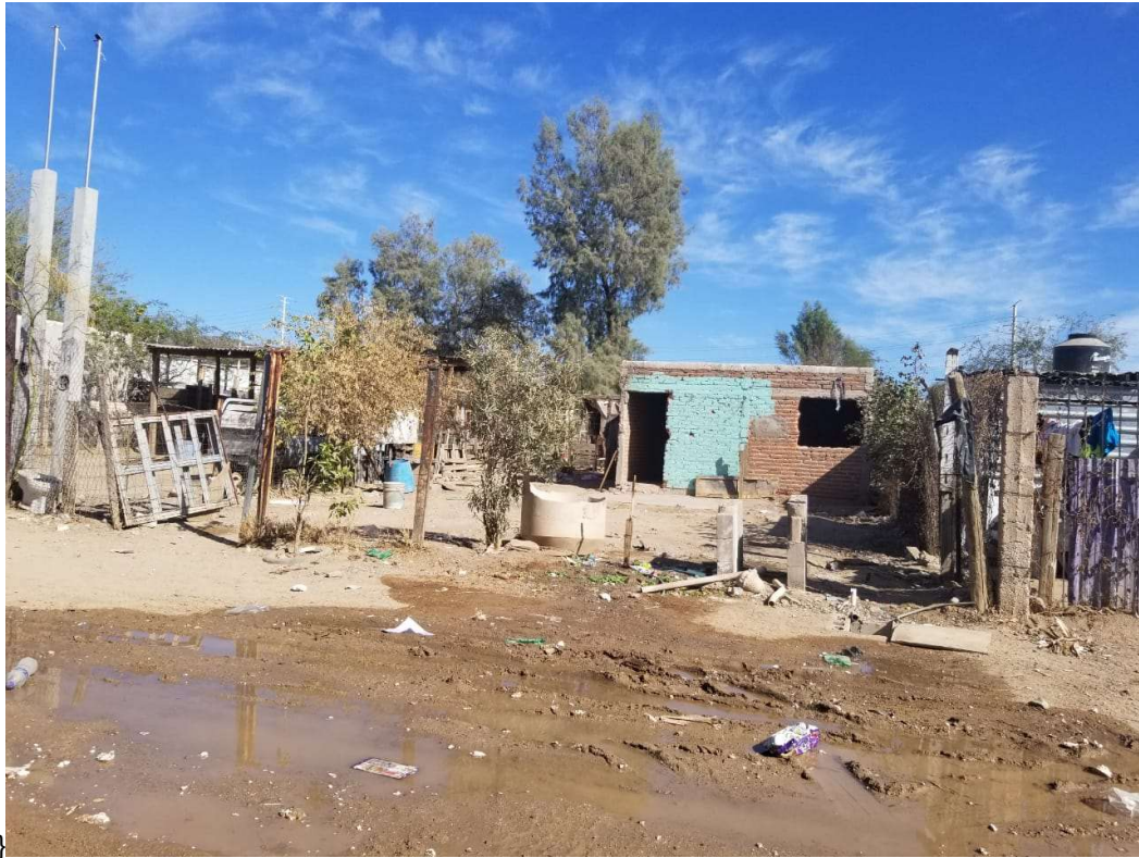
Figura 8.2 Calle en mal estado en Colonia Unión Ladrilleros. Fuente: Propia.
