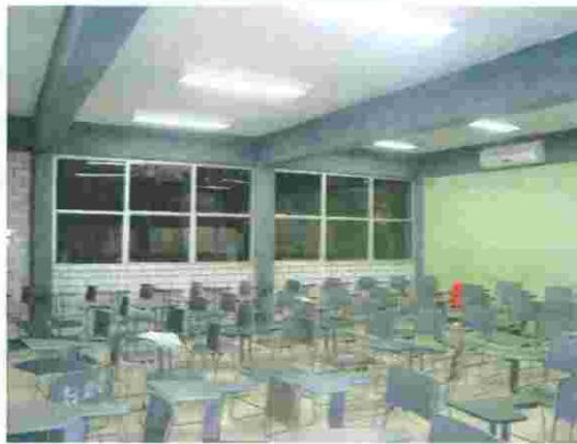
Foto 9.- Aulas solas con la iluminación encendida a las 12 pm.
