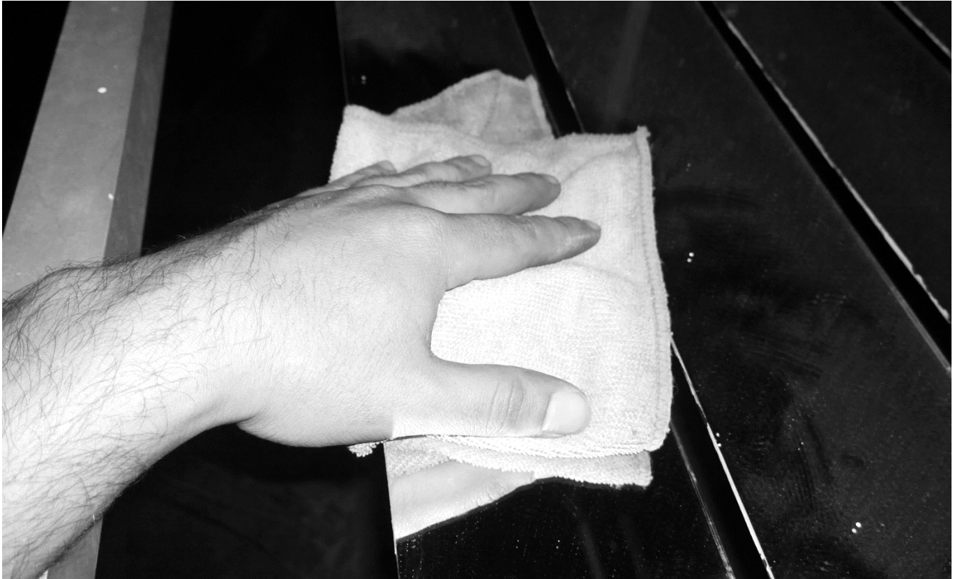
Figura 4. Limpieza en seco de espejos reflectores.
